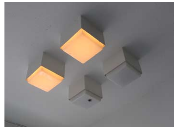
Tornien ruokailu- ja yhteistiloissa sekä kansliaosaston hallissa käytetty valaisintyyppi jota sommiteltu joko neljän tai kahden valaisimen ryhmiin.
