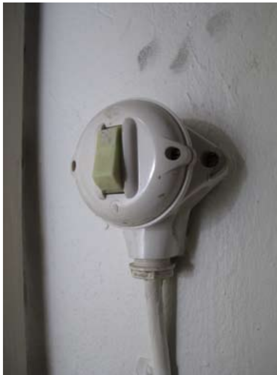
1960-luvun pinta-asennettu kytkin kellarissa.
