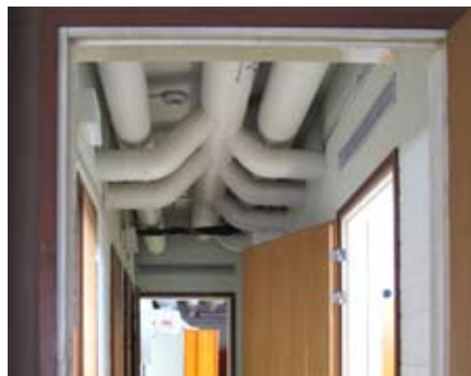
Monitoimikeskuksen alakattojen "raaka" ulkoasu muodostuu valkeaksi maalatuista betonipinnoista ja sillä täällä risteilevistä ilmanvaihtokanavista sekä kaapelihyllyistä.
