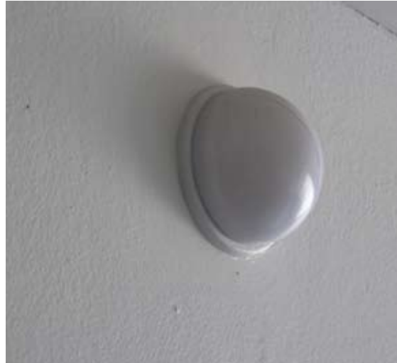
1960-luvun pinta-asennettu kytkin kellarissa.
