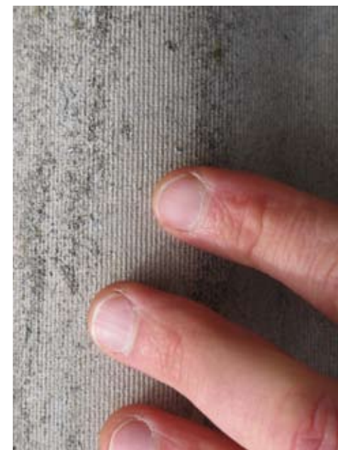
Minerit-pintaa länsijulkisivulla n. 45 vuoden säävaikutusten jälkeen.
