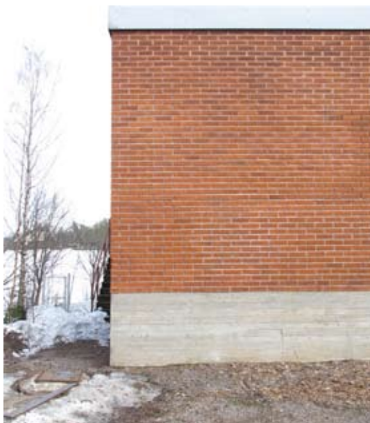
Monitoimikeskuksen julkisivun peruspinta: lautamuottipintainen betonisokkeli, harjattu punatiili punasävyisin pystysaumoin jälkisaumattuna ja julkisivun päättävä leveä räystäspeltti.
