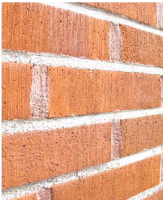
"Nykyisin suositellaan saumauksen suorittamista välittömästi muuraustyön yhteydessä joko kauhan kärjellä tai erilaisilla saumaraudoilla. Tämä on paras ja myöskin edullinen työtap. Haluttaessa värillinen laastin luonnollisesta väristä poikkeava sauma joudutaan koko laasti värjäämään. Usein värisaumaus suoritetaan kuitenkin siten, että seinä muurataan avosaumoin ja saumaustyö suoritetaan erillisenä työvaiheena. Peruslaastina käytetään tavallisimmin kalkkisementtilaastia KS 50/50."
