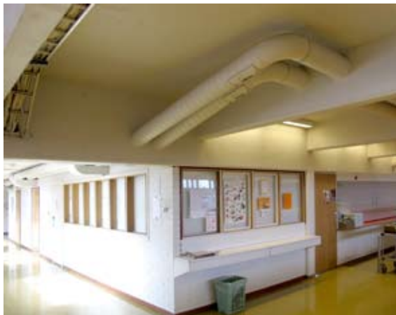
Monitoimikeskuksen alakattojen "raaka" ulkoasu muodostuu valkeaksi maalatuista betonipinnoista ja sillä täällä risteilevistä ilmanvaihtokanavista sekä kaapelihyllyistä.
