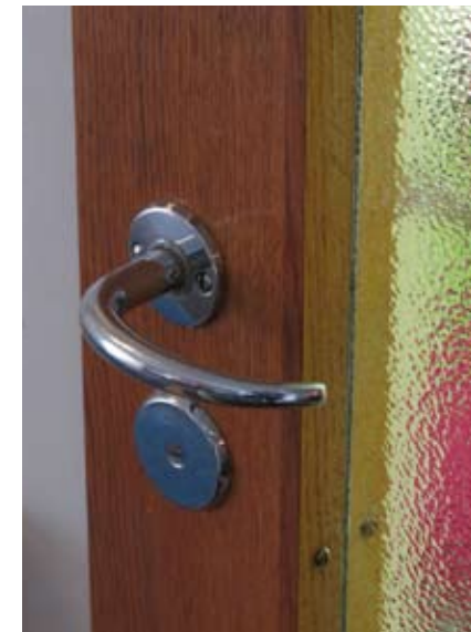
Solifer-sarana sellioivessa. Ovillehden uraruuvikiinnitys on vanhempi ja karmipuolen ristiuraruuvikiinnitys on nuorempi korjaus.
