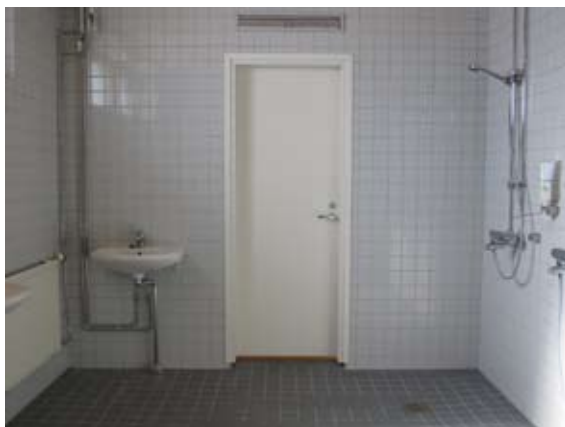
Ensimmäisen kerroksen henkilökunnan suihkuosasto on saneerattu hiljattain.
