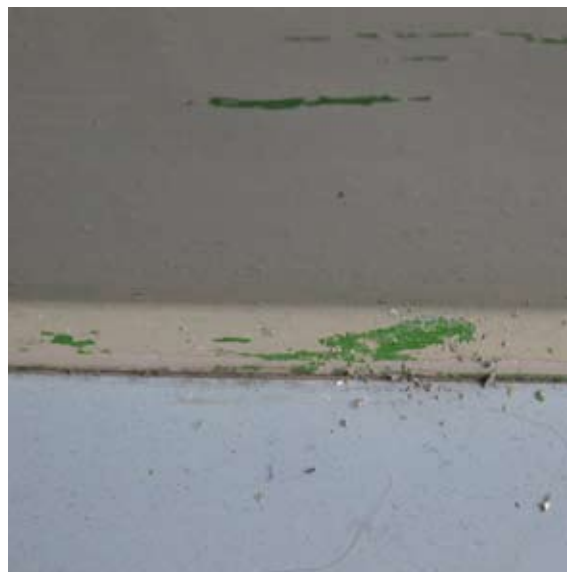
Peruslattioiden nykyinen materiaali on vaalean sininen muovilaatta ja muovinen jalkalista, joka sittemmin on ylimaalattu harmaaksi.
