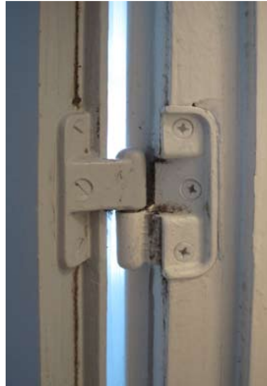
Solifer-sarana sellioivessa. Ovillehden uraruuvikiinnitys on vanhempi ja karmipuolen ristiuraruuvikiinnitys on nuorempi korjaus.
