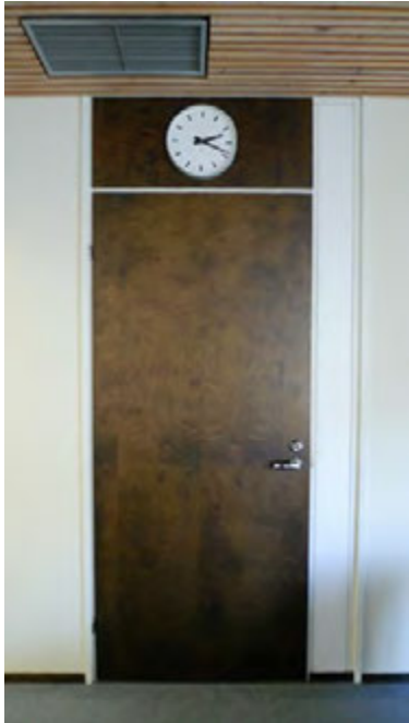
↑ Petsatut, viilutetut, huulleet laakaovet johtavat kolmannen kerroksen neuvotteluhuoneesta aulaan. am oy 2010.
