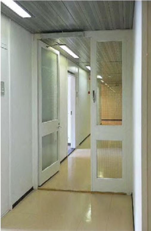
↑ Neljännen kerroksen käytävän teräsrakenteinen rautalankalasiovi. am oy 2010.
