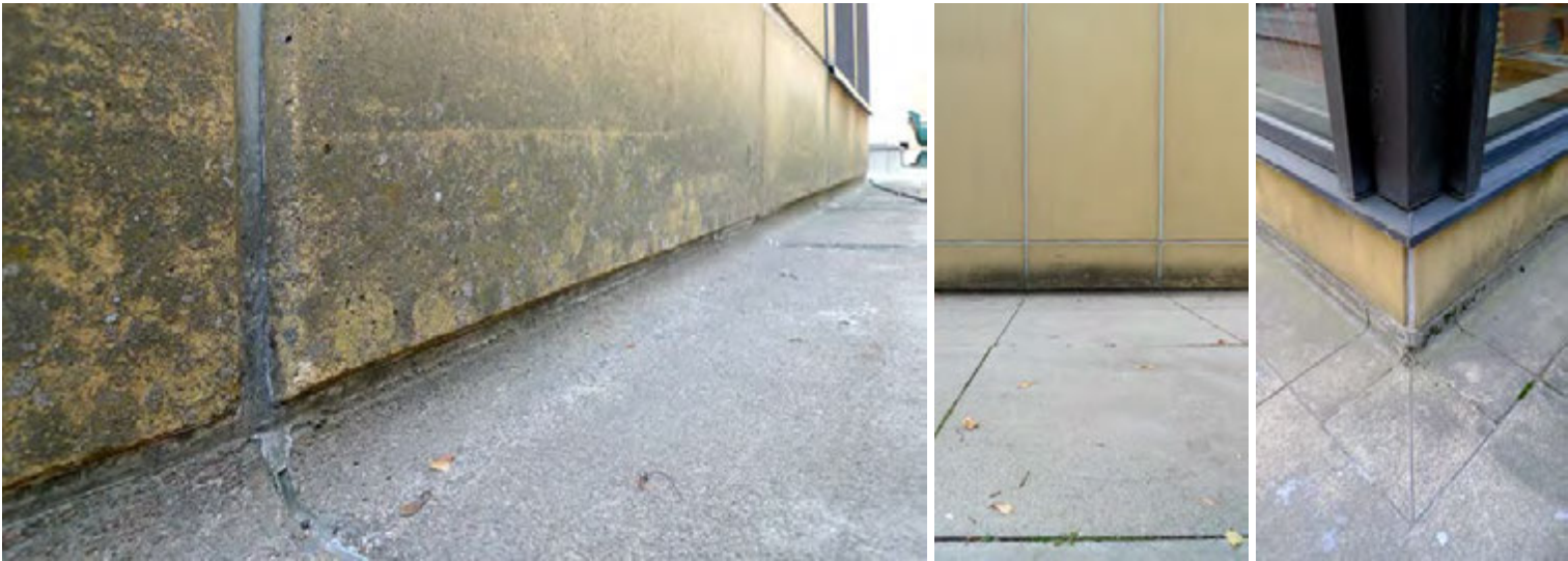
↓ Pihalaatituksen ja elementtiseinän liittymiä. am oy 2010. Ks. myös piirustus ARK 101 548, viereinen sivu.
