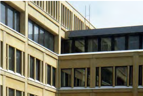
↑ Viidennen kerroksen räystääspellitys on alunperin jatkanut vie- reisen siiven ikkunapellityksen linjaa, niin että pellitysten ala- reuna on samassa tasossa. Kuva Simo Rista, OLA.
