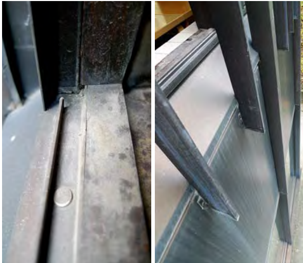
↓ Ylemmän kerroksen puuikkunan detaljointia. am oy 2010.
