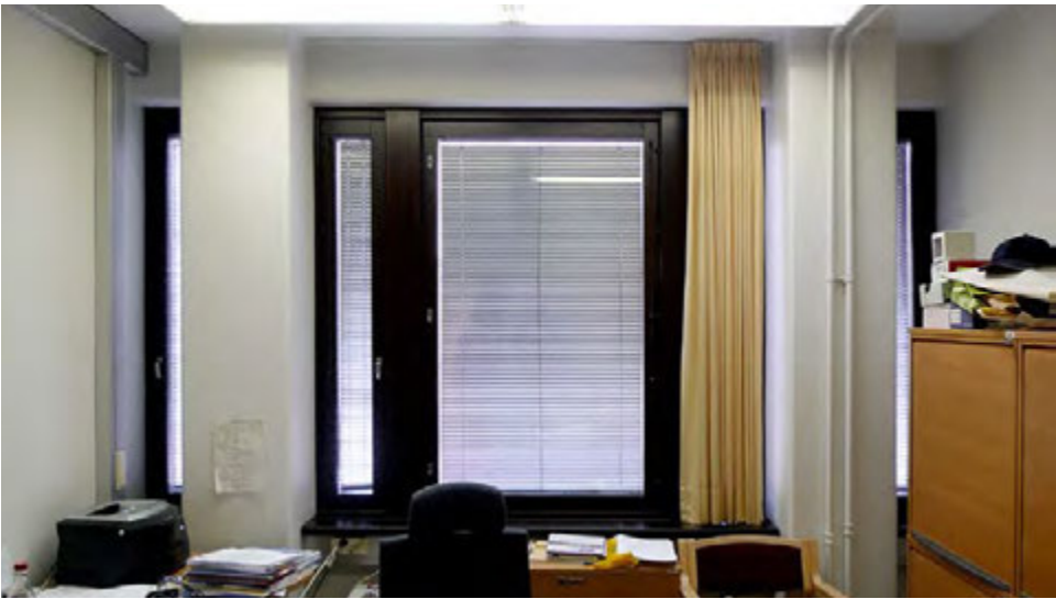
↑↑ Ikkunaseinillä kantavat pilarit vuorottelevat leveiden umpiosien kanssa. am oy 2010.
