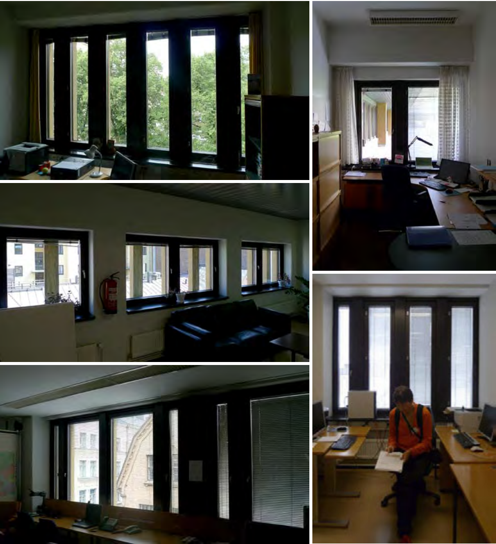
↑ Sisäasiainministeriön toimitalon puuikkunoita. am oy 2010.
