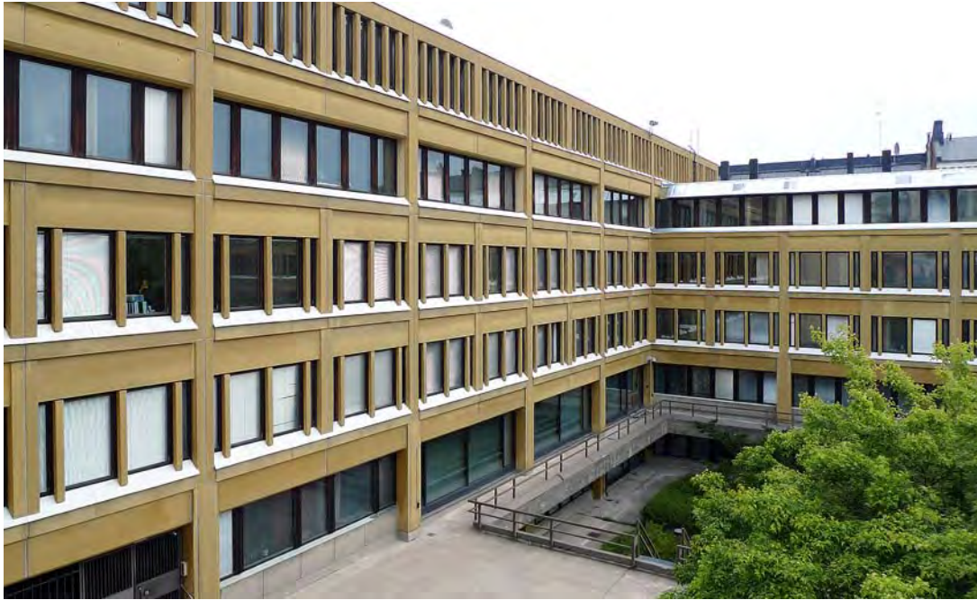
↑ Sisäpihan puolella pääaula avautuu pihalle suurten lasiseinien kautta. Ylempien kerrosten osalta katu- ja pihajulkisivut ovat lähes identtiset. am oy 2010.
