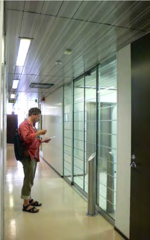
↑ Kolmannessa ja viidennessä kerroksessa hissiaula on erotettu käytävätilasta liukuovilla ja kulunvalvontalaitteella. am oy 2010.
