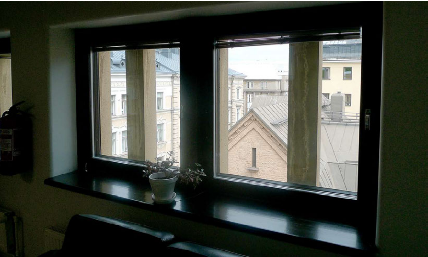
↑ Kuudennen kerroksen päätyaulan ikkuna. Elementtiripojen [R2, kts. piirustus ARK 84 571, sivu 37] taustapuoli on poikkeuksellisesti näkyvissä. am oy 2010.
