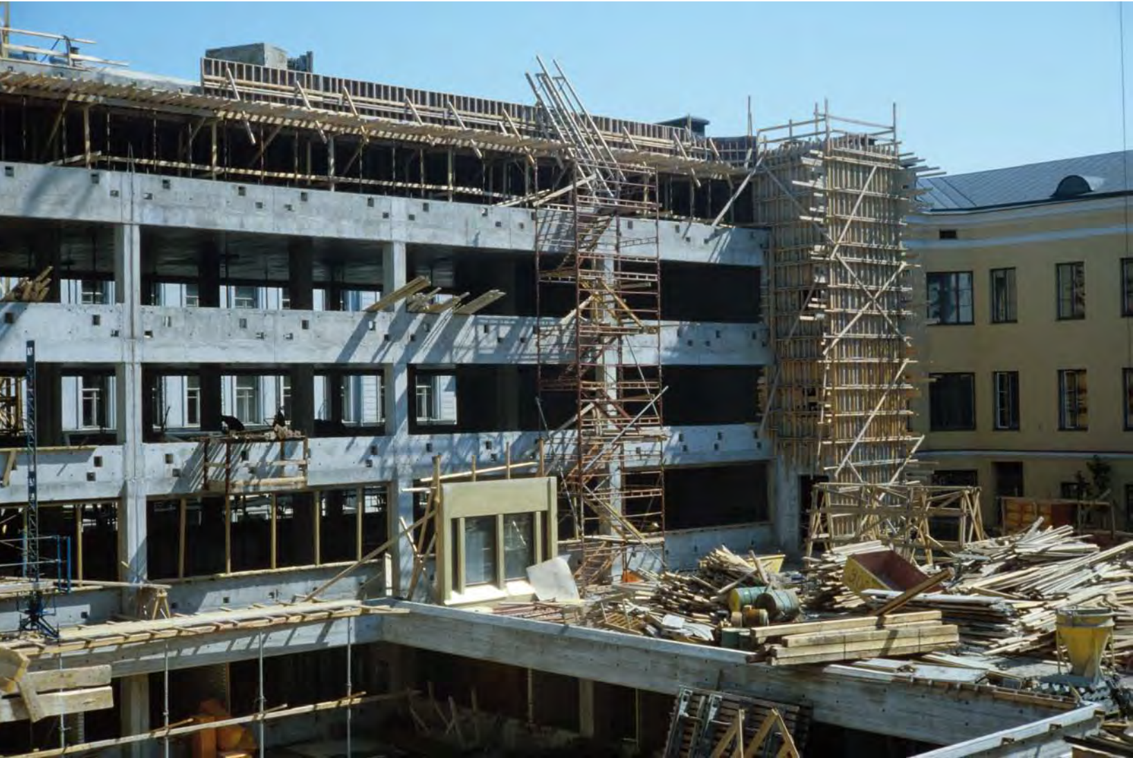
↑ Kuva rakennustyömaalta, rakennuksen Kirkkokadun puoleinen siipi sisäpihalta katsoen. Rakennuksen kantava runko on näkyvissä ennen kuorielementtien asentamista. Alhaalla keskellä julkisivuelementti. OLA.
