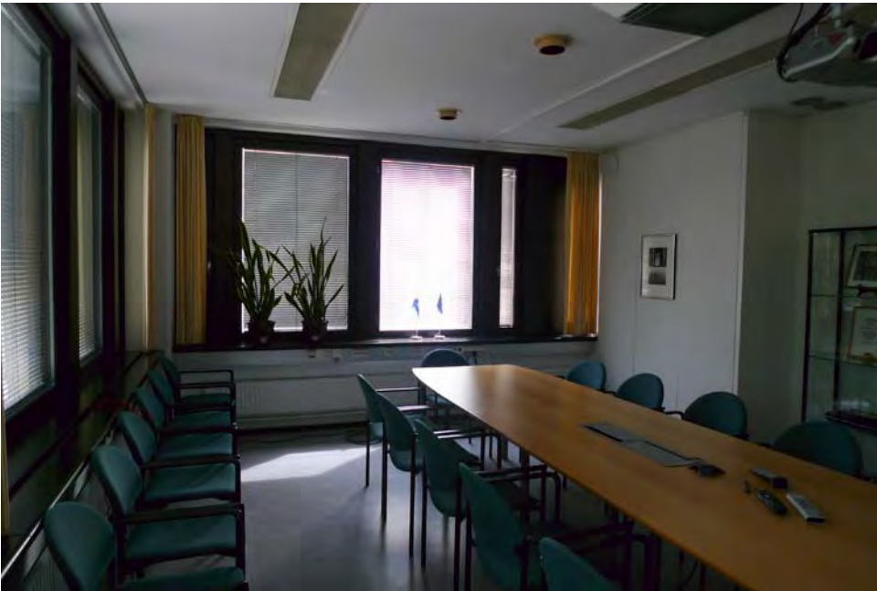
↑ Kolmannen kerroksen neuvotteluhuoneen katto on säilynyt alkuperäisasussaan valaisimineen. Lattian tekstiilimatto on vaihdettu linoleumiin, seinillä pellavapintainen Halltex-levytys on korvattu lasikuitupintaisella levyllä.
