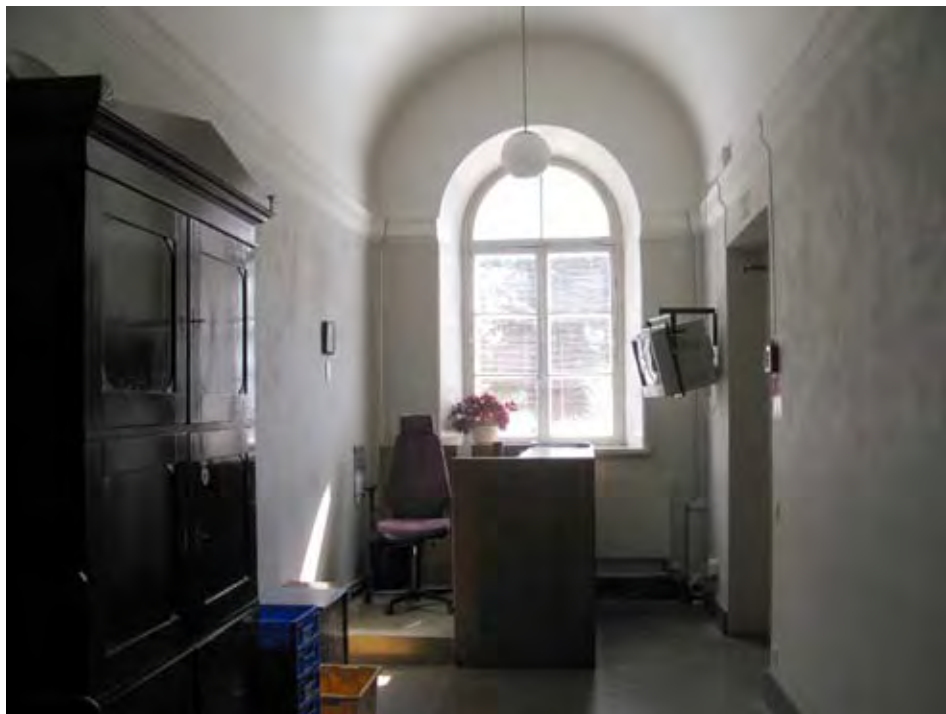
Eteläisen porrashuoneen itäpuolella oleva huone yhdistettiin jälleen ensimmäisen kerroksen ympäryskäytävään huonetilan 101 välityksellä. Huoneesta pois puretun porrashuoneen johdosta tilan seinät rapattiin uudestaan ja katon tynnyriholvi toteutettiin uudestaan. Uusi karheapintainen rappaus ilman vuosisataisia maalikerroksia on pintana elävä, joten maalin sävy vaihtelee valon osumisesta riippuen.
