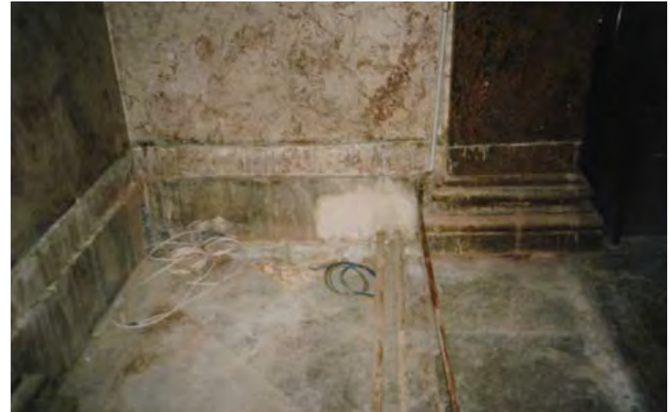
Korokkeen purkutyön yhteydessä jouduttiin stukkopinnan alaosiin, vanhan korokkeen kiinnityskohtaan tekemään korjauspaikkaus. Kuva Arkkitehtitoimisto Helander-Leiviskä
