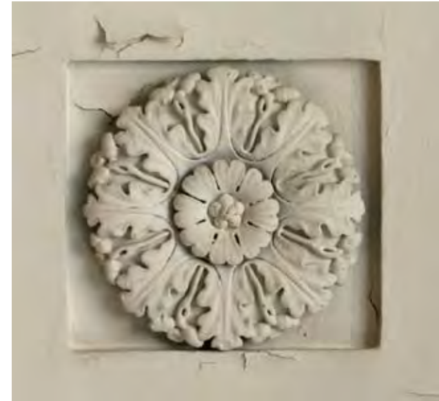
Pohjoisen porrashuoneen kattoruusuke kuvattuna 2009. Osa ruusukkeista on uusittu tulipalon jälkeen 1827, osa peruskorjauksen yhteydessä 1970-luvun lopulla.
