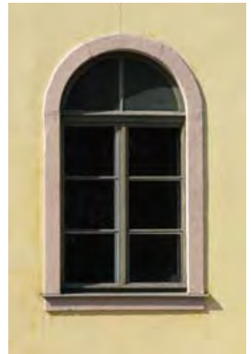
Katujulkisivujen peruspintojen ikkunatyypit nykyasussa, ylinä kolmas kerros, alin ensimmäinen kerros. Perusseinäpintojen kehykset ovat nykyään osittain rapattuja, osittain graniittisia, mutta kehykset on maalattu yhtenäisen vaikutelman aikaansaamiseksi. Kuvat Okulus 2009
