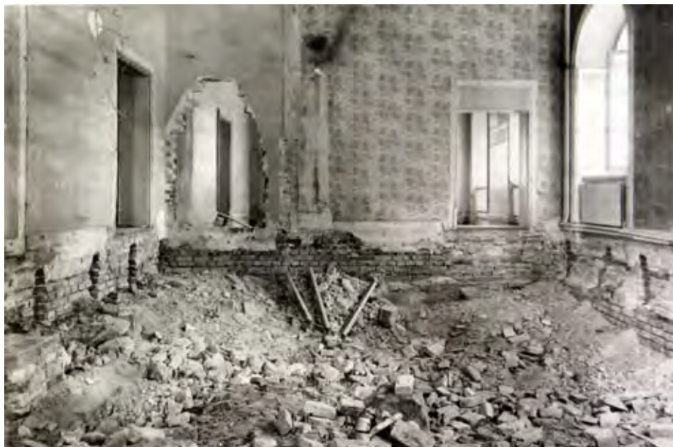
Paloturvallisuuden nimissä rakennuksesta purettiin pois paljon vanhoja rakenteita, ensimmäisestä kerroksesta lähes kaikki puurakenteiset lattiat. Alla näkyy purkutyön yhteydessä esiin tullut rautojen varaan tehty tulisijan alusrakenne. Kuvat MVRHO
