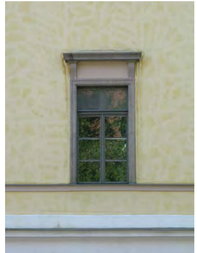
Keskirisaliitin toisen kerroksen ikkunoiden graniittiset, profiloituneet kehykset sekä ylälistaa kannattelevat konsolit osallistuvat keskirisaliitin korostamiseen. Perusseinäpinnalla ikkunoita kehystää profiloimattomat, yksinkertaiset kehykset. Okulus 2009
