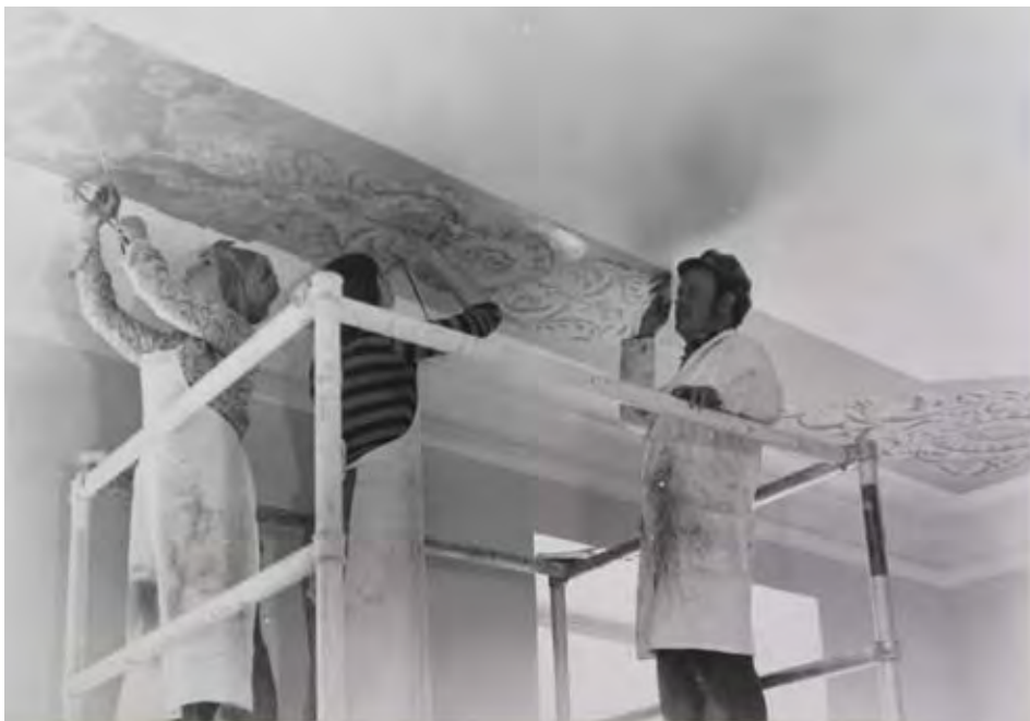
Yhteensä neljän katon koristelujen fragmentaarinen esiin otto ja uudelleen maalaaminen oli kohtalaisen suuri tehtävä. Kuva MV/RHO
