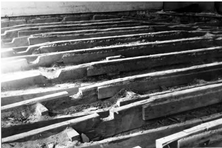
Yllä ensimmäisen kerroksen lounaisesta siivestä (huone 157) peruskorjauksen yhteydessä tehty lattiarakenteiden purku toi esiin Gjörwellin aikaisen käytäväseinän perustuksen. Alla huoneessa 206 oleva lattia-ansarakanne paljaana peruskorjauksen aikana. Rakenne on joko alkuperäinen tai palon jälkeinen. Kuvat MV/RHO
