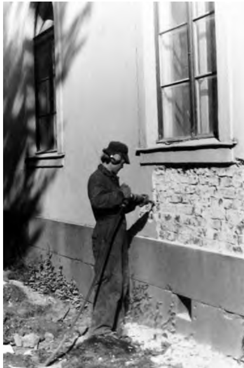
Kuvasarja rappauksen pudottamisesta ja rappaustyöstä. Rappauksia poistettaessa julkisivun koristeiden alkuperäinen rakenne tuli näkyviin. Konsolit ovat graniittia ja räystästä kantavat kivilaatat. MV/RHO
