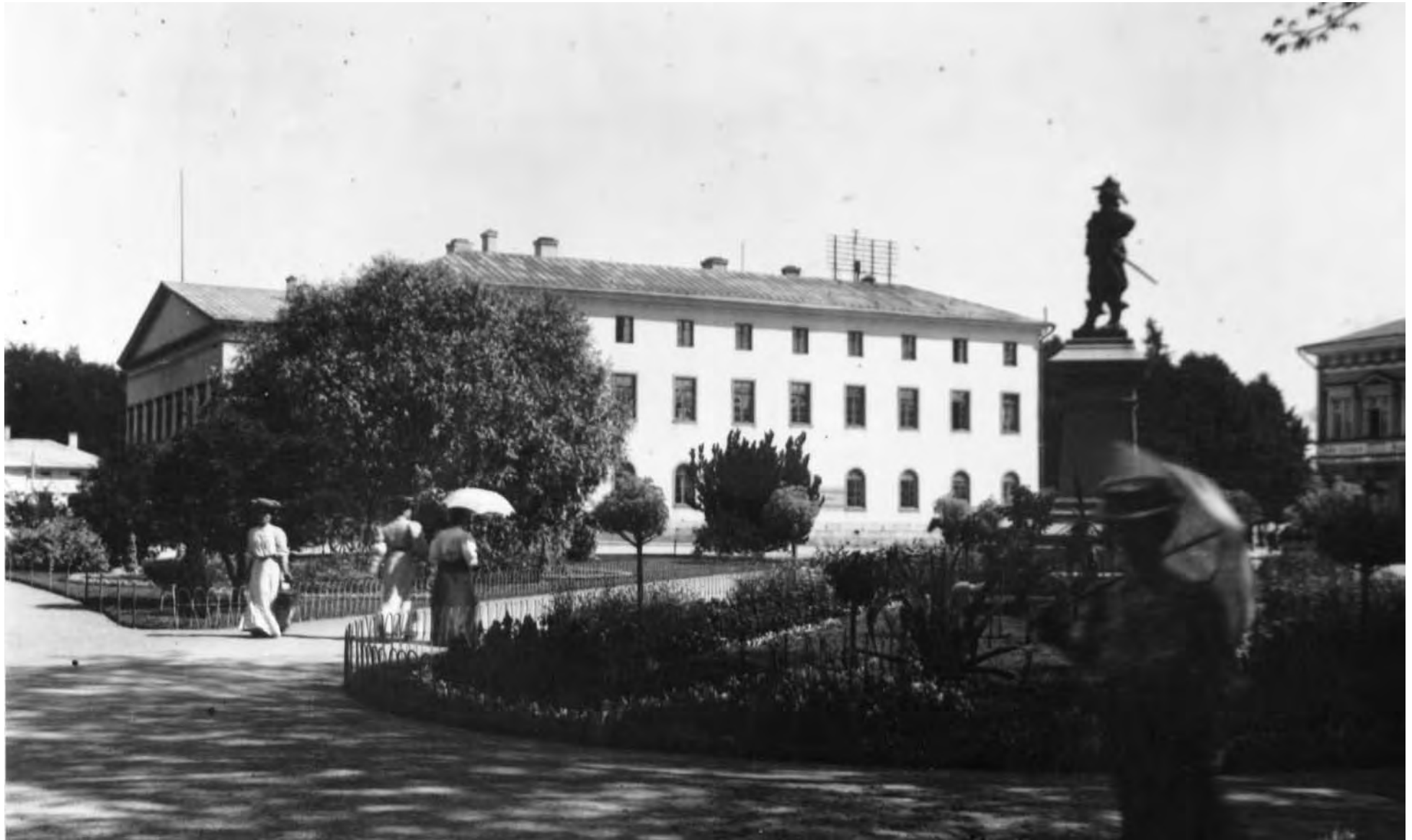
Akatemiatalo noin vuonna 1908. Julkisivun nykyistä voimakkaampi kontrasti rapatun julkisivupinnan ja ikkunakehysten välillä kiinnittää huomiota. MVKA
