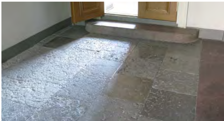
Itäisen porrashuoneen alkuperäistä kalkkikiviladontaa. Kuvan oikeassa laidassa näkyy portaissa käytettyä punaista graniittia.
