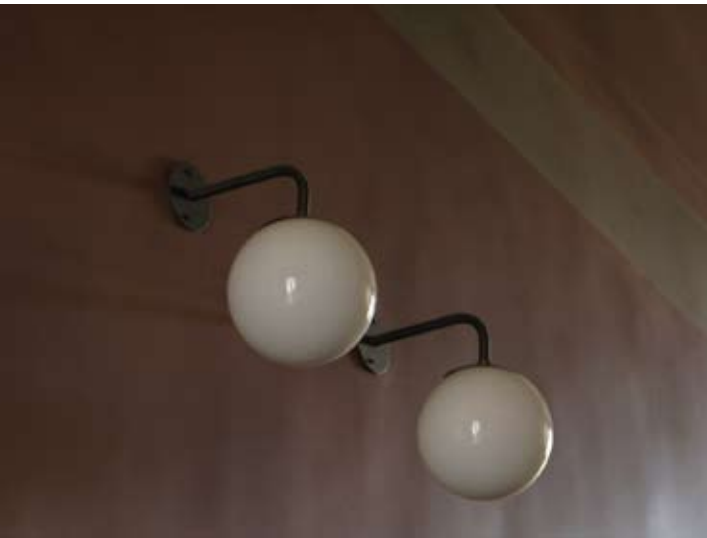
Peruskorjauksen yhteydessä tilaan suunnitellut seinälampeit.
