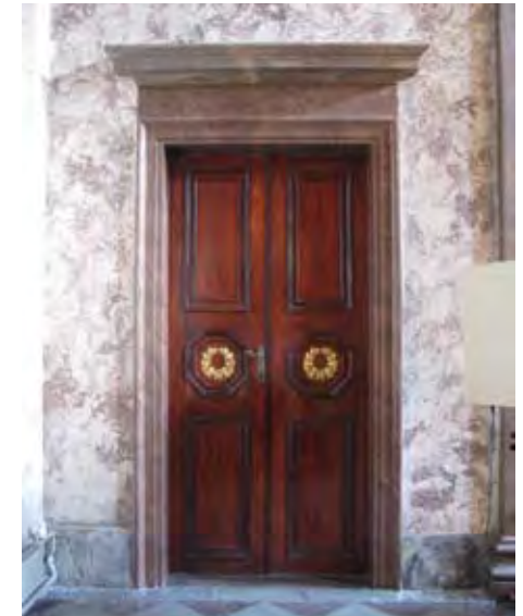
Nykyiset sivuovet, kuten pääovetkin, ovat peräisin J. Ahrenbergin johtamasta muutosvaiheesta noin 1910.
