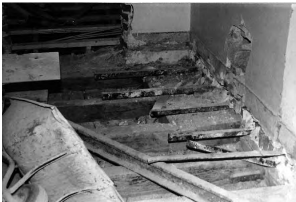
Paloturvallisuuden nimissä rakennuksesta purettiin pois paljon vanhoja rakenteita, ensimmäisestä kerroksesta lähes kaikki puurakenteiset lattiat. Alla näkyy purkutyön yhteydessä esiin tullut rautojen varaan tehty tulisijan alusrakenne. Kuvat MVRHO
