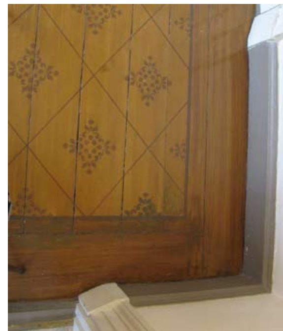
Oikealla vanhan mallin mukaan toteutettu lattiamaalaus, jota on käytetty tiloissa 235 ja 266. Okulus 2009
