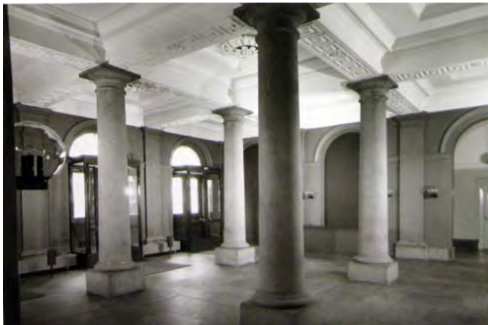
Vestibyyli peruskorjauksen jälkeen. Vestibyyli on edelleen pitkälti samassa asussa. MVKA/Welin
