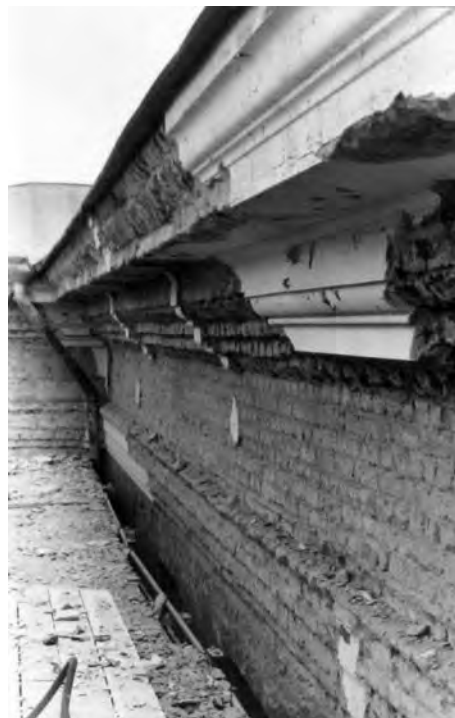
Kuvasarja rappauksen pudottamisesta ja rappaustyöstä. Rappauksia poistettaessa julkisivun koristeiden alkuperäinen rakenne tuli näkyviin. Konsolit ovat graniittia ja räystästä kantavat kivilaatat. MV/RHO
