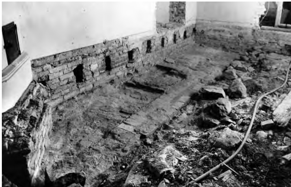
Yllä ensimmäisen kerroksen lounaisesta siivestä (huone 157) peruskorjauksen yhteydessä tehty lattiarakenteiden purku toi esiin Gjörwellin aikaisen käytäväseinän perustuksen. Alla huoneessa 206 oleva lattia-ansarakanne paljaana peruskorjauksen aikana. Rakenne on joko alkuperäinen tai palon jälkeinen. Kuvat MV/RHO
