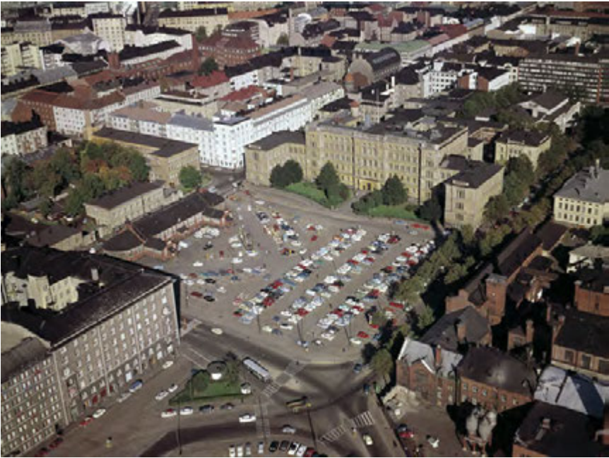
Kuva 1960-l. Pihan vehreys leimaa myös 1960-luvun ilmapärikuvaa. Samassa kuvassa erottuvat pihan keskelle rakennetut matalat puurakennukset. HKM
