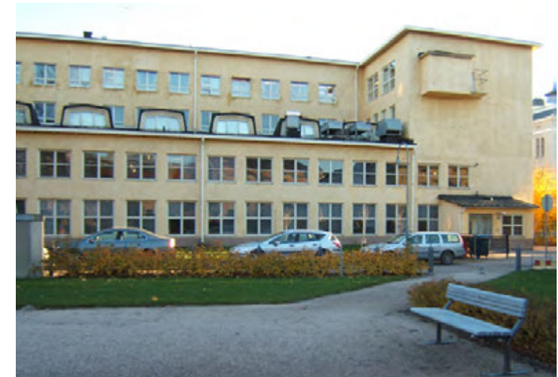
Pihanpuoleinen konepajasiipi yläikkunoineen
