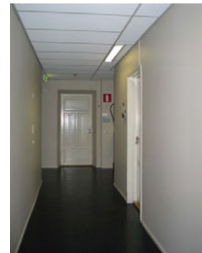
Uusi toimistokäytävä alaslaskettuine kattoineen
