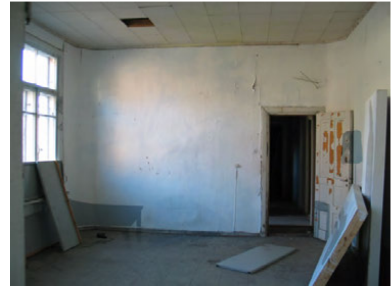
Eristysrakennuksen rapatut hirsiseinät pyöristettyine sisänurkkineen. MSKS 2007
