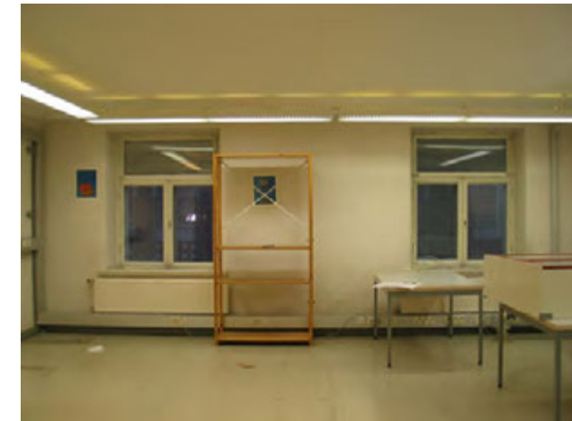
1. kerroksen entiset laboratoriohuoneet 2007
