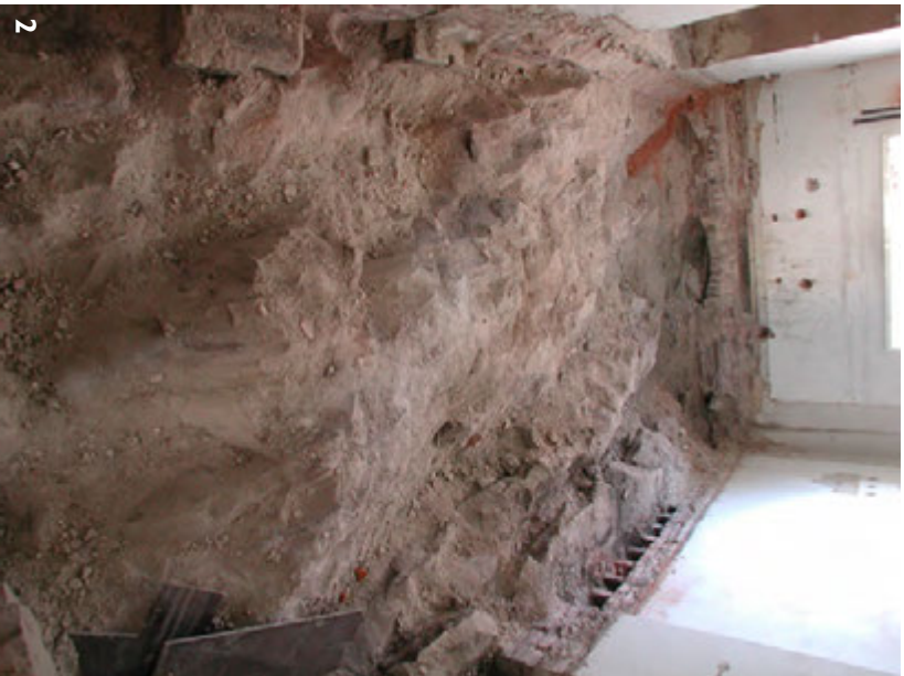
Kuva 5: Samainen, tulevan sähköpääkeskuksen sijainti louhintatyön jälkeen, elokuussa 2002.
