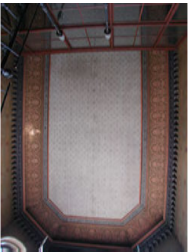
Katto- ja listapiintoja ennen töiden alkua
