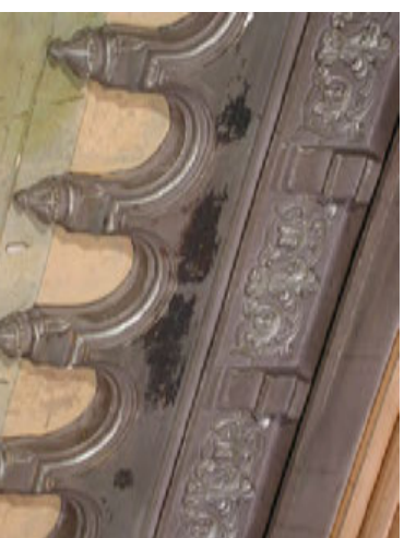
Metallikiiltainen kipsilista oli paikoin mustunut, ilmeisesti jonkinlaisen kemiallisen reaktion seurauksena
