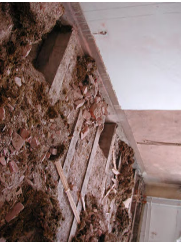
Huoneen 118 avattua lattiaa. Alapohjan täytteessä on täytemateriaalina käytetty rakennusajkaista ”jätemateriaalia” mm. tilienpaloja sekä hiekkaa ja pintakerroksessa kahunsammalta.
