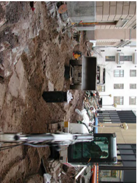
Pihan vanhat pintarakenteet poistettiin, kaukolämpö-, vesi- ja sähköliittymät uusittiin. Rakennuksen läheltä kalliopintaa kaivettiin esiin ja pintaa muokattiin betonivalulla siten, että sadevesien valuminen rakennuksen alle estettiin.
