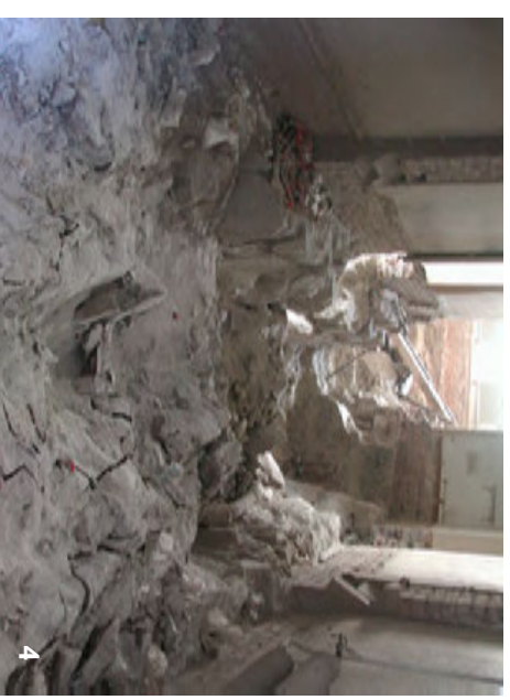
Kuva 1: huoneen 113 maavarainen lattia avattiin, täyttökerrokset poistettiin ja huoneeseen valettiin uusi betonilattia Kuva 2: huoneen 108 maavarainen lattia avattiin ja maakerrokset kuorittiin pois. Taloteknisten vetojen sijoittamiseksi jouduttiin tekemään pienehköä louhintaa Kuva 3: Huoneen 114 uuden betonilattian valumuotti Kuva 4: Uuden sähköpääkeskuksen maavarainen alapohja purettiin. Kallio-pinta oli hyvin lähellä ja tällä alueella louhintatyötä jouduttiin tekemään yli metrin verran. Kuva kesäkuulta 2002, jolloin louhintatyö oli käynnissä. Kuvan etualalla näkyvät kalliossa olevat halkemat ovat "etanalla" tehdyn louhintatyön jälkeä.
