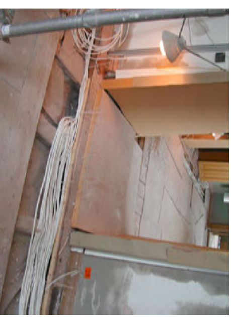
Sähkön lattiakanavat täytyivät joissain huoneissa, toisissa taas kanavassa kulki vain muutama johto. Alla näkyy kanavan avaamisen ongelma maalaustyön jälkeen, kanavat kitattiin maalilla käytännössä umpeen, eikä saumoja avattu.
