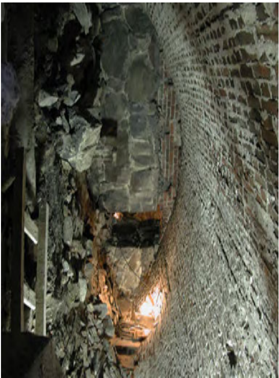
Yllä: Kellaritila huoneen 121 alapuolella; lohkaremuurauksen yläpuolella näkyy tiilimuurauksen alareuna
