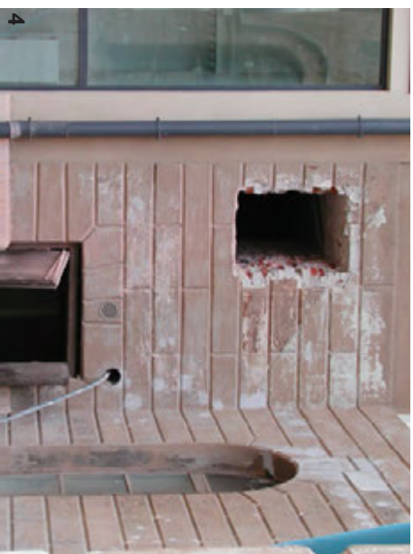
Kuva 3 Pihajulkisivun ensimmäisen kerroksen pohjoisosassa oli pieni alue keltaista, tuukkaa maalia, jota ei saatu poistettua pinnasta.
