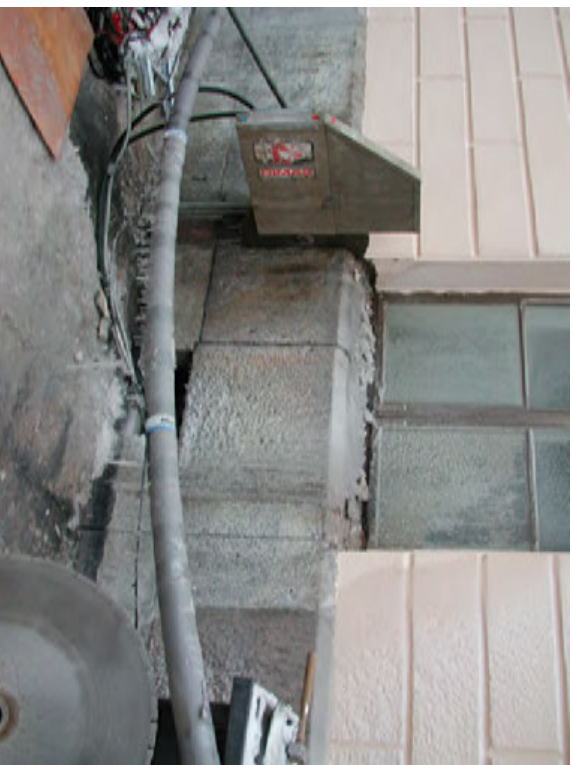
Yllä uuden aukon avausta, alla muutostyö lähes valmiina
