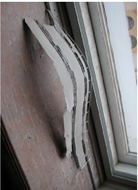
Yllä kattolistojen ja tarvittaessa kattopintojen paikkauksessa käytettyä pahvitettua rappausverkkoa. Laastina käytettiin Knaufin kipsilaastia
