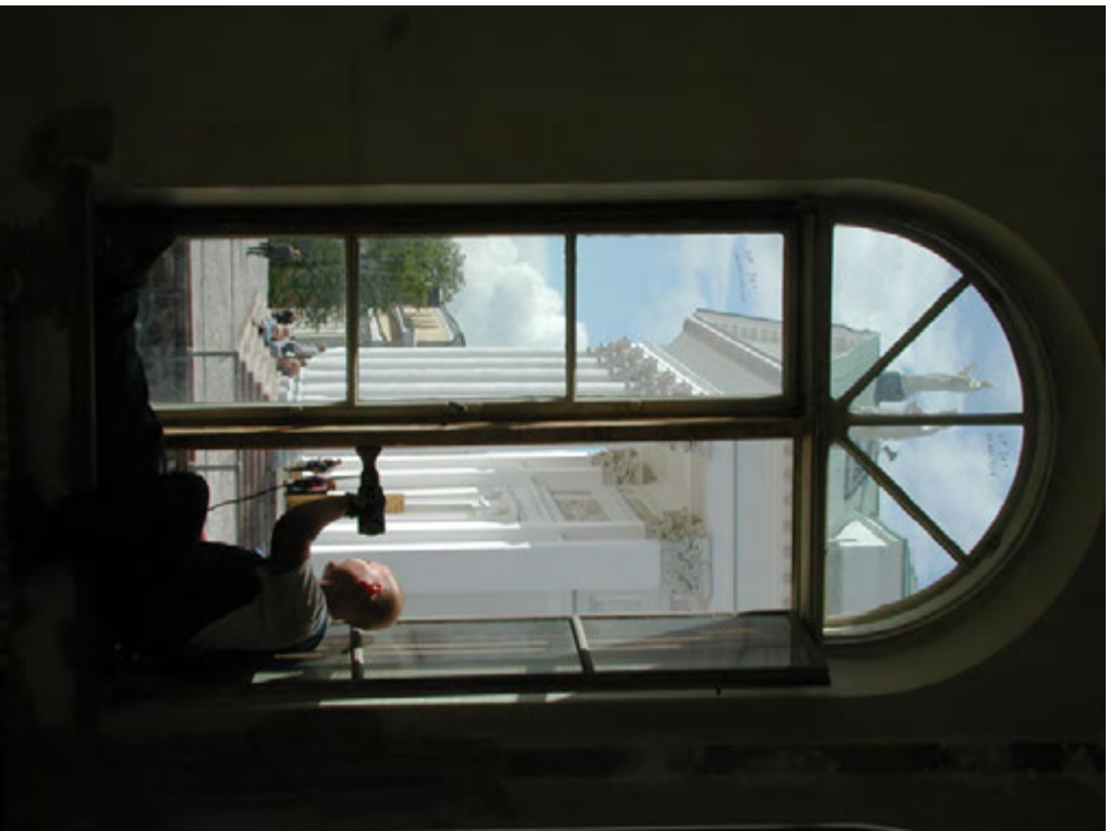
Kesäpäivinä Arppeanumin peruskorjaustyömaa oli suorastaan idyllinen. Kuvassa käynnissä maalnpoisto ikkunan välkarmista.
