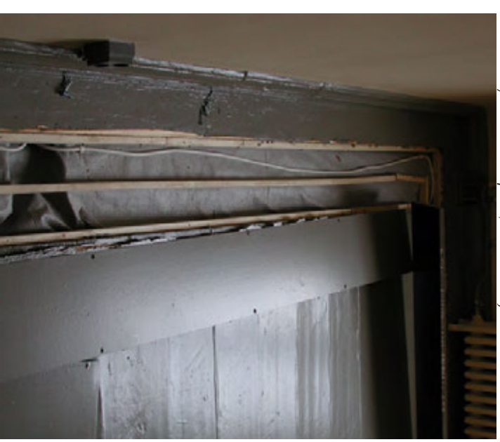
Sähkön lattiakanavat täytyivät joissain huoneissa, toisissa taas kanavassa kulki vain muutama johto. Alla näkyy kanavan avaamisen ongelma maalaustyön jälkeen, kanavat kitattiin maalilla käytännössä umpeen, eikä saumoja avattu.
