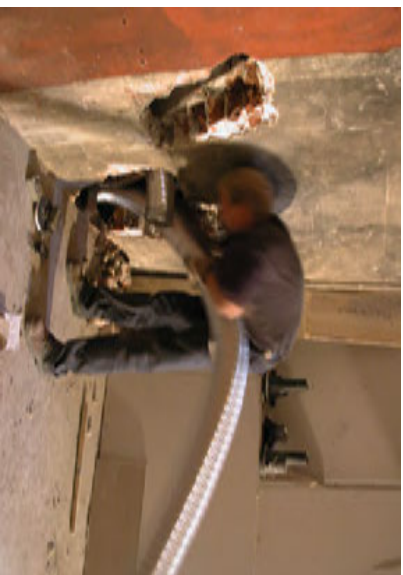
Taipuisan IV-putken syöttöä ullakolta alaspäin
