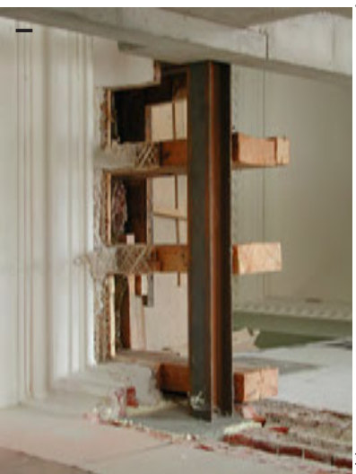
Kuva 2 Toisen kerroksen yläpohjan tikurappaus "rispaantui" paikoin avauksien ympäriltä; betonirakenteen ja kalkkikiekkatiilien muodostama kokonaisuus näkyy kuvassa havainnollisesti
