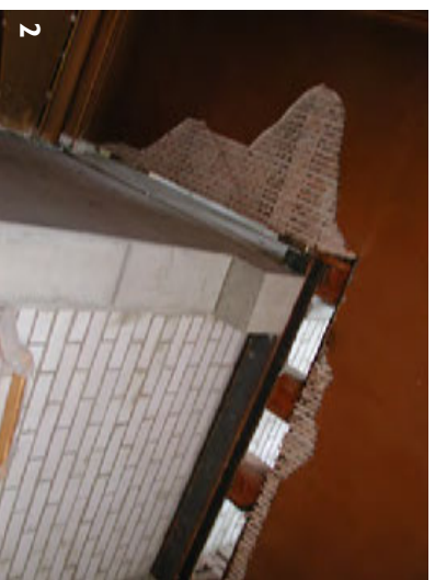
Kuva 2 Toisen kerroksen yläpohjan tikurappaus "rispaantui" paikoin avauksien ympäriltä; betonirakenteen ja kalkkikiekkatiilien muodostama kokonaisuus näkyy kuvassa havainnollisesti
