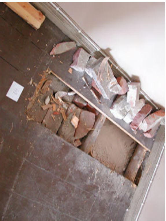
Rakennetutkimuksen avauksia kesältä 2001
