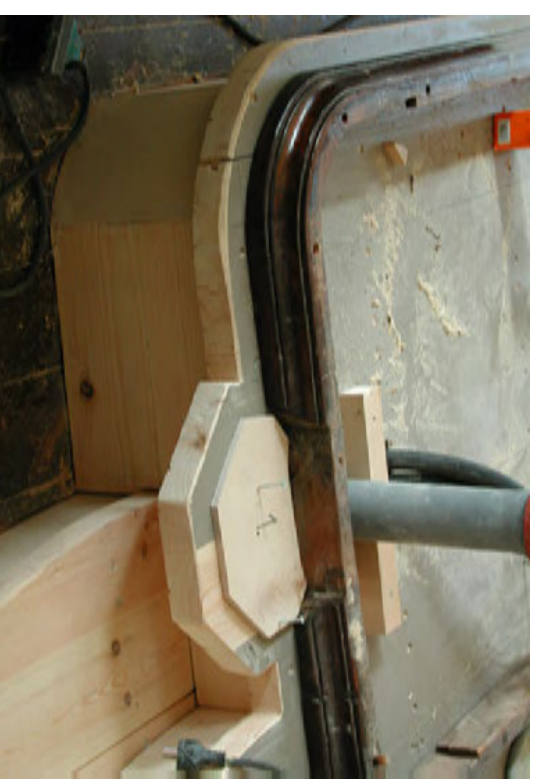
Kateederin koko perustus rakennettiin uudestaan
