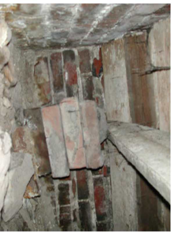
Huoneen 108 alla olivat holvimuurauksen muurausaikaiset tuet säilyneet hyvin matalan ryömintätilan ansiosta. Muotoon veistetty lauta tukeutuu tiilestä ladottujen ”pylväiden” varaan ja kannattelee lankkupohjaa, jonka päälle holvimuuraus on ladottu. Myös korkeammissa kellaritiloissa oli palkkoitten näkyvissä tiilestä ja laastista kasattuja matalia pylväitä. Puurakenteiset telukset ovat ilmeisesti olleet käytössä useampaan kertaan.
