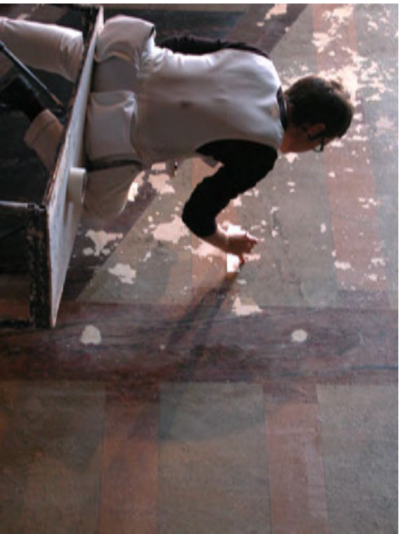
Alla konservattori Arja Kuusitie paikkakorjaustyyössä. Keskellä näkyy pohjustustyön kolme vaihetta: tasoitteen levitys, reunojen tarkka rajausta ja shellakalla eristäminen. Oikealla konservattoirin paletti.
