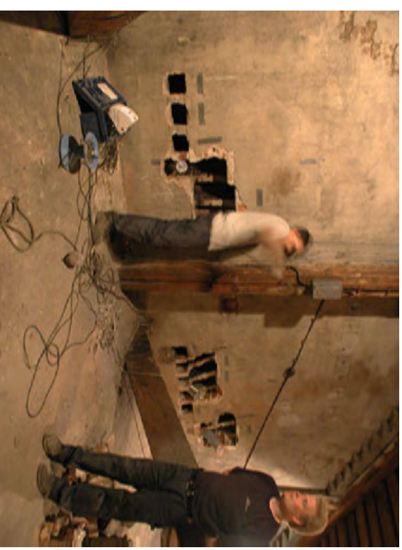
Suomen hormistosaneeraus Oy:n toimesta hormit luodattiin videokameran avulla. Kaikki käyttökelpoiset hormit pyrittiin hyödyntämään ilmanvaihdon tarpeisiin.
