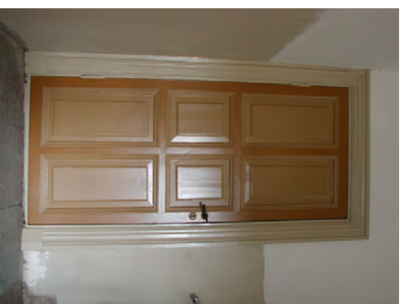
Kuvat: Vierisellä sivulla keittiöportaan pintoja ennen peruskorjausta, tällä sivulla maalaus- töiden valmistuttua
