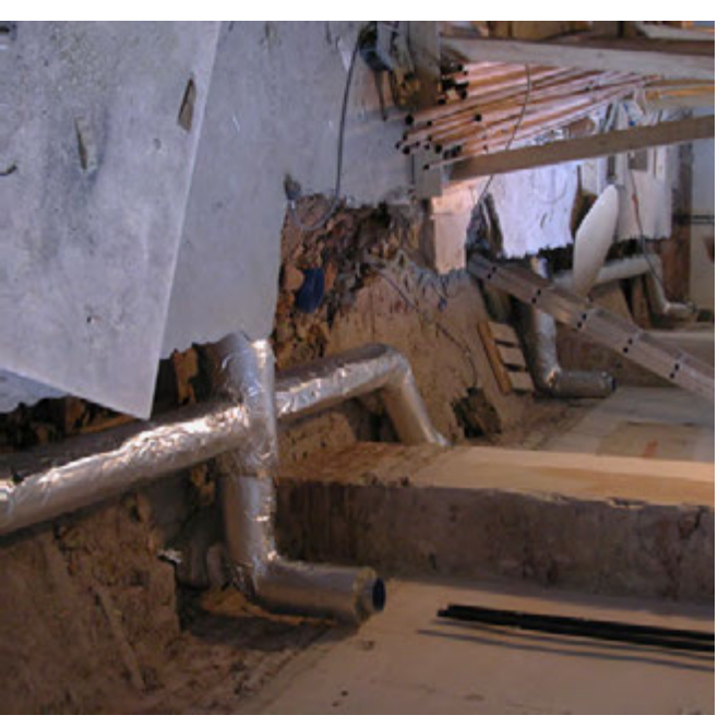
Huoneessa 121 avattiin vanhaa lattiarakennetta kellarin kautta tuotujen tulolimakanausten sijoittamiseksi
