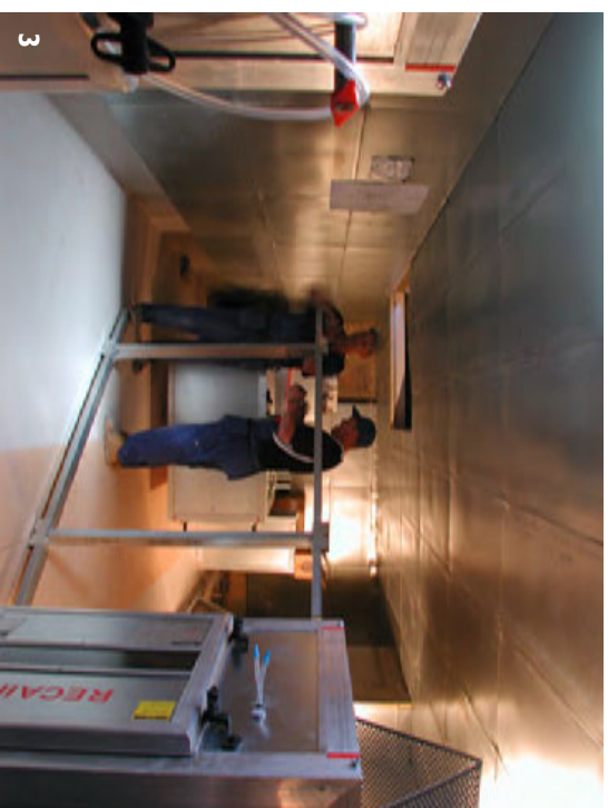
Kuva 1: Entinen ullakkohuone purettiin ja tilaan rakennettiin eteläinen ilmanvaihtokonehuone. Kuvassa näkyy myös ansarakenteen vahvistus ja suojaus
