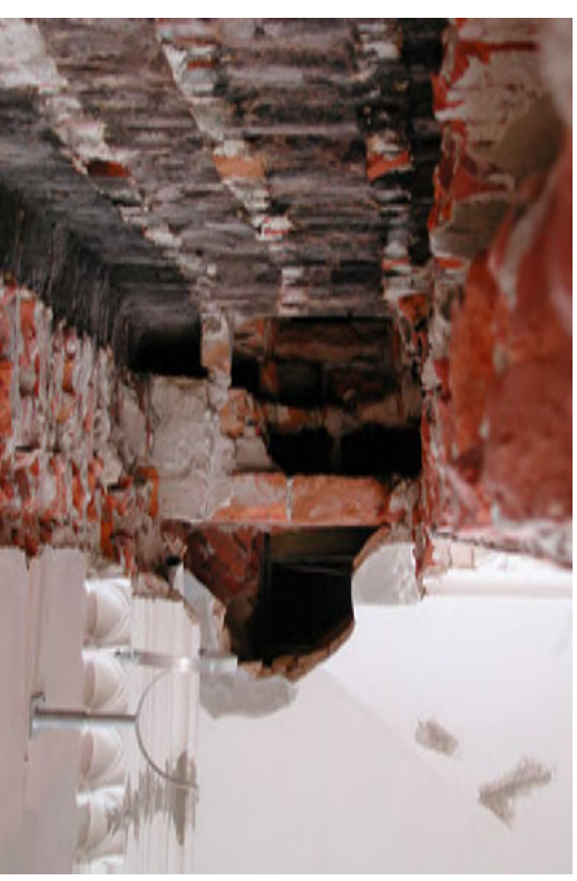
Yllä: Ullakolla hormit on koottu piippuihin, joten hormit nousevat ullakkotiassa vinosti muurin sisällä.
