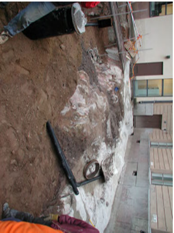
Pihan vanhat pintarakenteet poistettiin, kaukolämpö-, vesi- ja sähköliittymät uusittiin. Rakennuksen läheltä kalliopintaa kaivettiin esiin ja pintaa muokattiin betonivalulla siten, että sadevesien valuminen rakennuksen alle estettiin.
