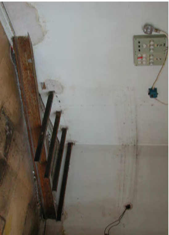
Huoneen 320 kaakkoisnurkasta purettiin pois teräsrakenteinen laboratorio-käyttöä varten tehty laitealusta. Vanha lankkulattia oli peitetty ruuvi kiinnityllä lastulevyllä ja muovimatolla.
