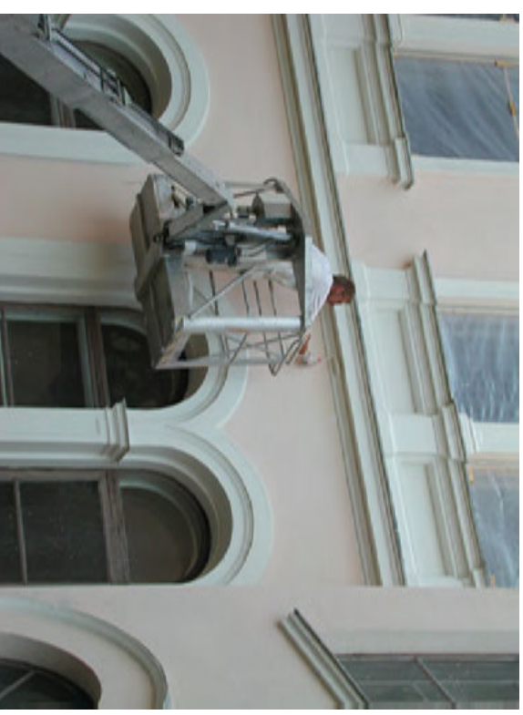
Pikän pihajulkisivun kaikki työt tehtiin nosturista käsin.
