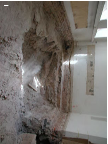
Kuva 1: huoneen 113 maavarainen lattia avattiin, täyttökerrokset poistettiin ja huoneeseen valettiin uusi betonilattia Kuva 2: huoneen 108 maavarainen lattia avattiin ja maakerrokset kuorittiin pois. Taloteknisten vetojen sijoittamiseksi jouduttiin tekemään pienehköä louhintaa Kuva 3: Huoneen 114 uuden betonilattian valumuotti Kuva 4: Uuden sähköpääkeskuksen maavarainen alapohja purettiin. Kallio-pinta oli hyvin lähellä ja tällä alueella louhintatyötä jouduttiin tekemään yli metrin verran. Kuva kesäkuulta 2002, jolloin louhintatyö oli käynnissä. Kuvan etualalla näkyvät kalliossa olevat halkemat ovat "etanalla" tehdyn louhintatyön jälkeä.
