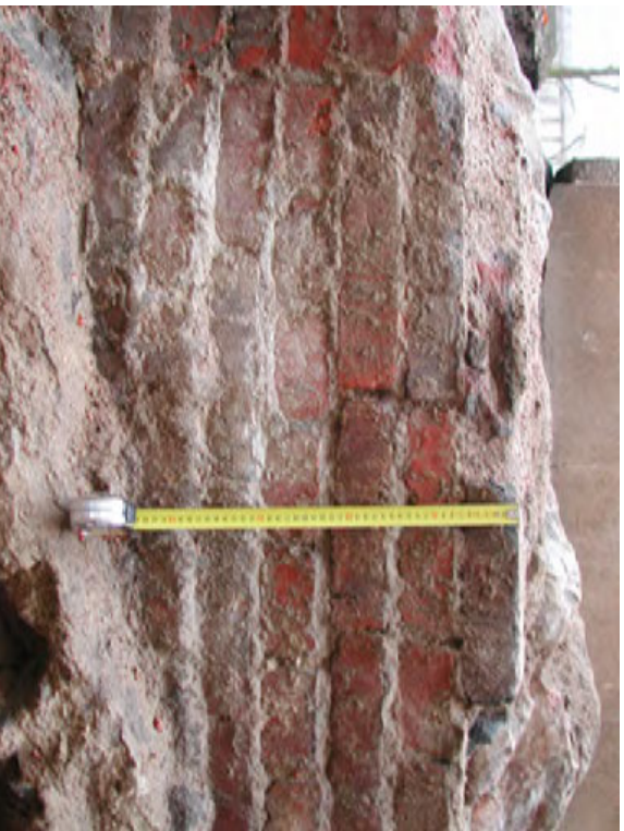
Pihatöiden yhteydessä esille tullut kaareva, rakennusta vanhempi muurin-pätkä, jonka tarkkaa ikää ei ryhdytty määrittelemään. Muuri sai jäädä paikalleen uusien täyttökerrosten sisään.
