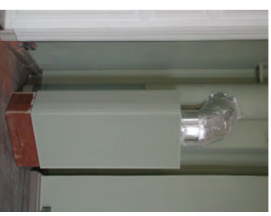
Sali 404 ennen tuloihmalinten viimeistä maalausta; alla vasemmalla: Myös elinten maalausta seinän väriin kokeiltiin, mutta päädyttiin maalaamaan elimet kaikissa huoneissa lämpimän harmaalla.
