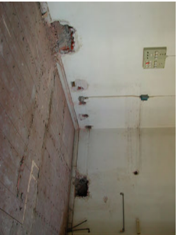
Huoneen 320 kaakkoisnurkasta purettiin pois teräsrakenteinen laboratorio-käyttöä varten tehty laitealusta. Vanha lankkulattia oli peitetty ruuvi kiinnityllä lastulevyllä ja muovimatolla.
