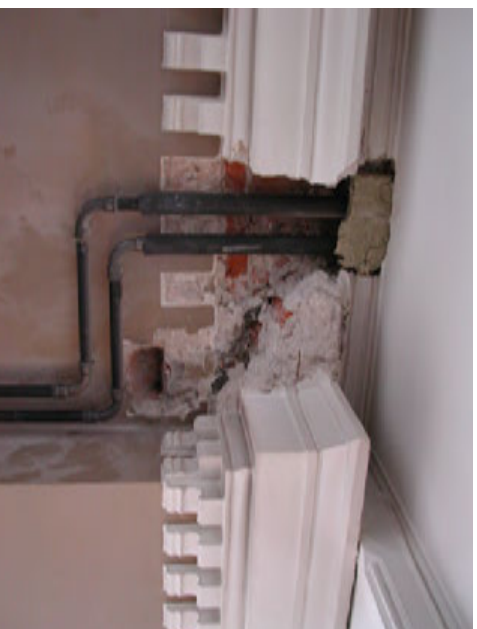
Auditorion eteläseinällä putkien läpiviennit...
