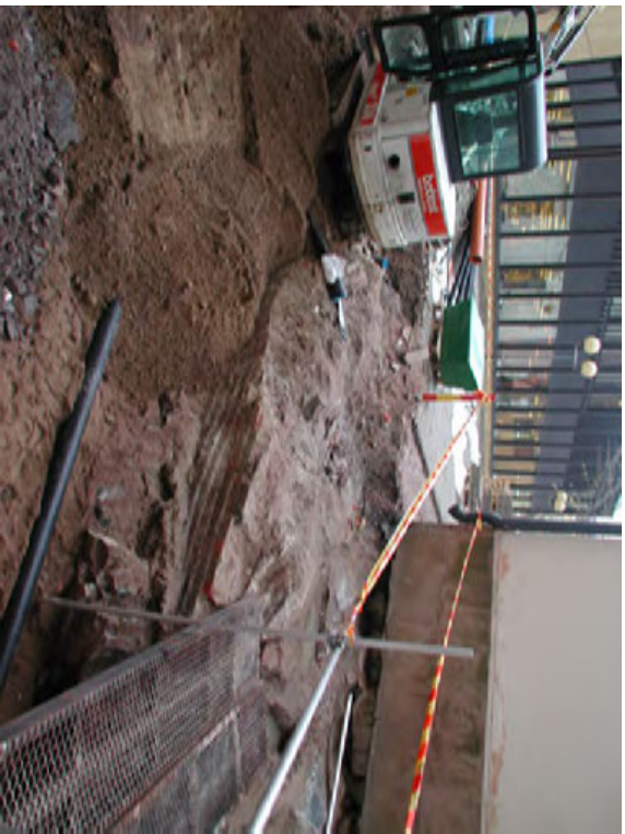
Pihatöiden yhteydessä esille tullut kaareva, rakennusta vanhempi muurin-pätkä, jonka tarkkaa ikää ei ryhdytty määrittelemään. Muuri sai jäädä paikalleen uusien täyttökerrosten sisään.
