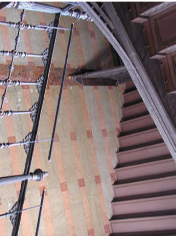
Yllä puhdistettua seinäpintaa: vaaleampana näkyvä alue on viimeisesti vuoden 1891 kerrostumaa, keltaisemmät nuorempaa, mutta kuitenkin jo iäkästä.
