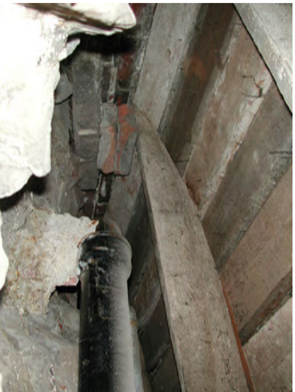
Huoneen 108 alla olivat holvimuurauksen muurausaikaiset tuet säilyneet hyvin matalan ryömintätilan ansiosta. Muotoon veistetty lauta tukeutuu tiilestä ladottujen ”pylväiden” varaan ja kannattelee lankkupohjaa, jonka päälle holvimuuraus on ladottu. Myös korkeammissa kellaritiloissa oli palkkoitten näkyvissä tiilestä ja laastista kasattuja matalia pylväitä. Puurakenteiset telukset ovat ilmeisesti olleet käytössä useampaan kertaan.
