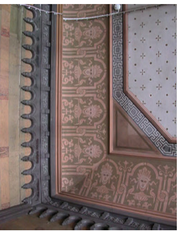
Todennäköisesti sekä katon että lepotasojen alapintojen pintakäsittelyt ovat peräisin vuodelta 1891.
