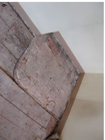
Yllä: Ullakolla hormit on koottu piippuihin, joten hormit nousevat ullakkotiassa vinosti muurin sisällä.
