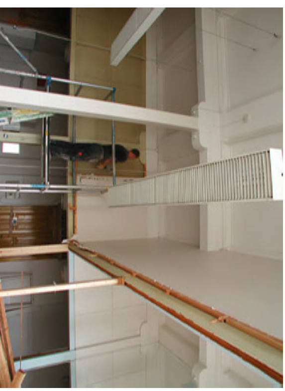
Alla: Kesän 2001 aikana tehtiin suurin osa purkutöistä. Kuvassa salin 303 keveiden väliseinien purkua. Yläpohjaa tukevat puupilarit jätettiin paikalleen.
