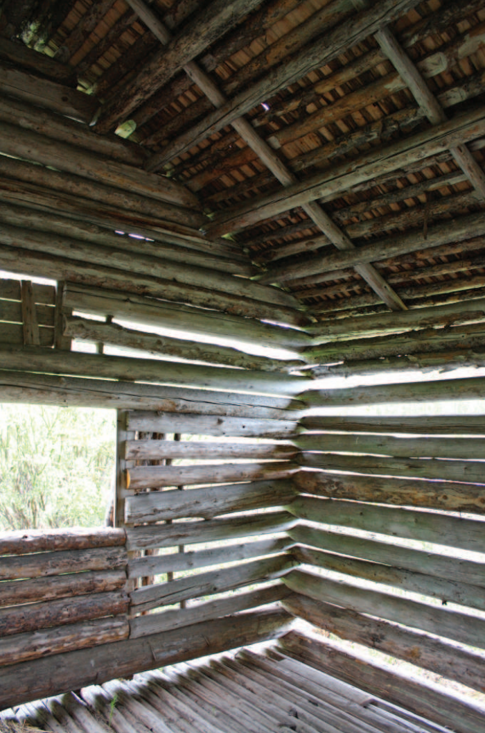
Kuva 112. Vittasuon lato. Ovena toimivat karapuuhan sopivaksi veistetyt iralliset vaakapuut, jotka nostettiin paikoilleen ladon täyttyessä. © Noora Puustinen 2014.
