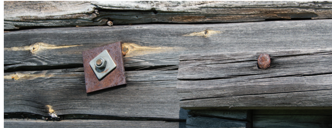
Kuva 205. Fölgjarit kiinnitettiin metallisilla ruuvipulteilla. Riihen seinä. © Juho Lesonen 2014.
