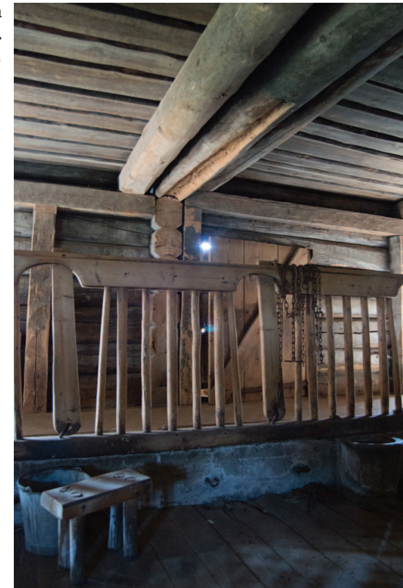
Kuva 103. Lehmien parret ja välipohjan niskahirret.
