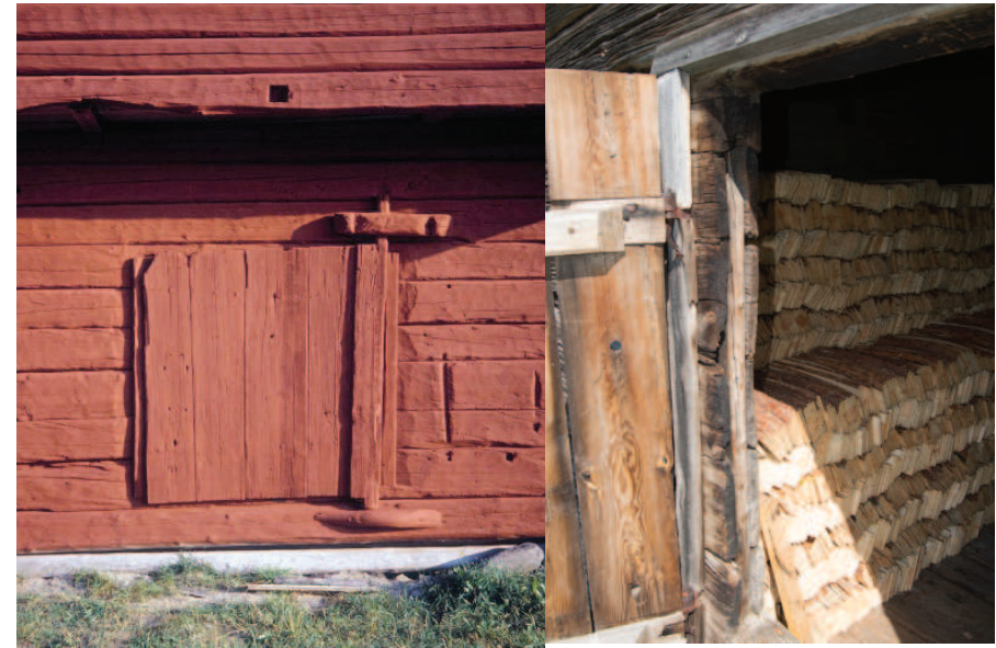
Kuva 41. Ruumenhuoneen ovipieli on vahvistettu heinälatojen tapaan karapuulla ja ovilehti kiinnitetty suoraan seinään.
