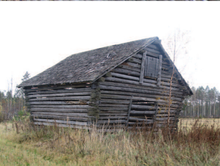
Kuva 113. Lamminahon yläriihilato. Lato levenee selvästi ylöspäin. © Helena Hirviniemi 2010, HH.
