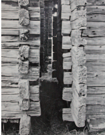
Kuva 18. Lamminahon rakennuksissa on käytetty pääasiassa pitkänurkkasalvoksia. Naisten aitan ja pikkuaitan nurkat.
