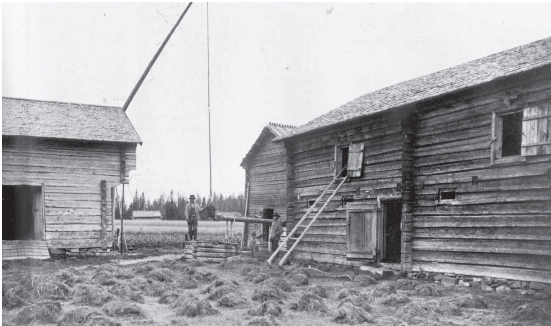
Kuva 139. Lamminahon piha 1885. Navetan välipohjien niskahirsien päät näkyvät julkisivussa. Navetassa ja luhdissa on jo pärekatot, mutta viinakööki on vielä malkakattoinen. Taustalla näkyvät vanha riihi ja vanha lato.
