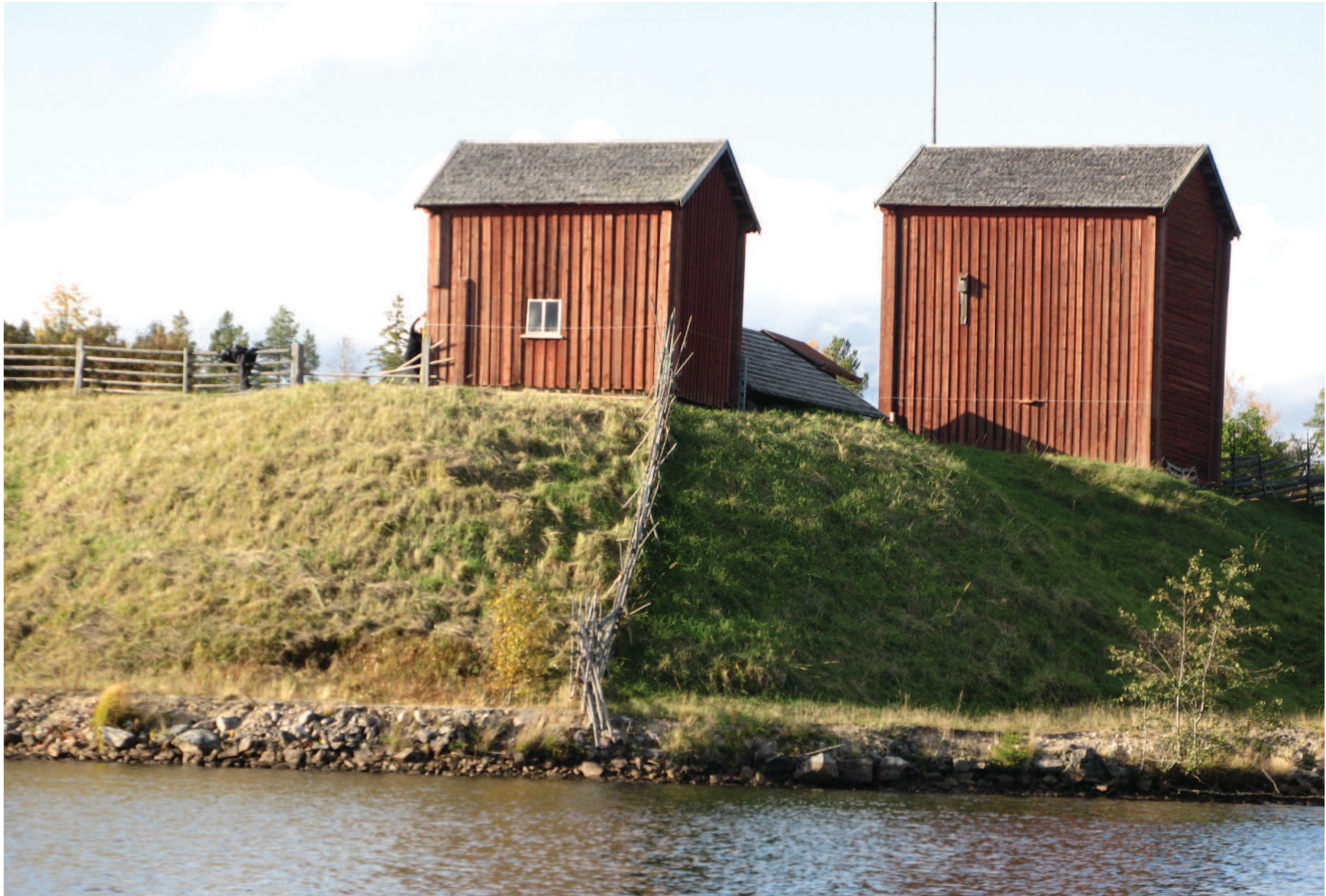
Kuva 123. Lamminahon törnäaitan ja puojin seinät on suojalaudoitettu etelänpuolelta. © Helena Hirviniemi 2009, HH.
