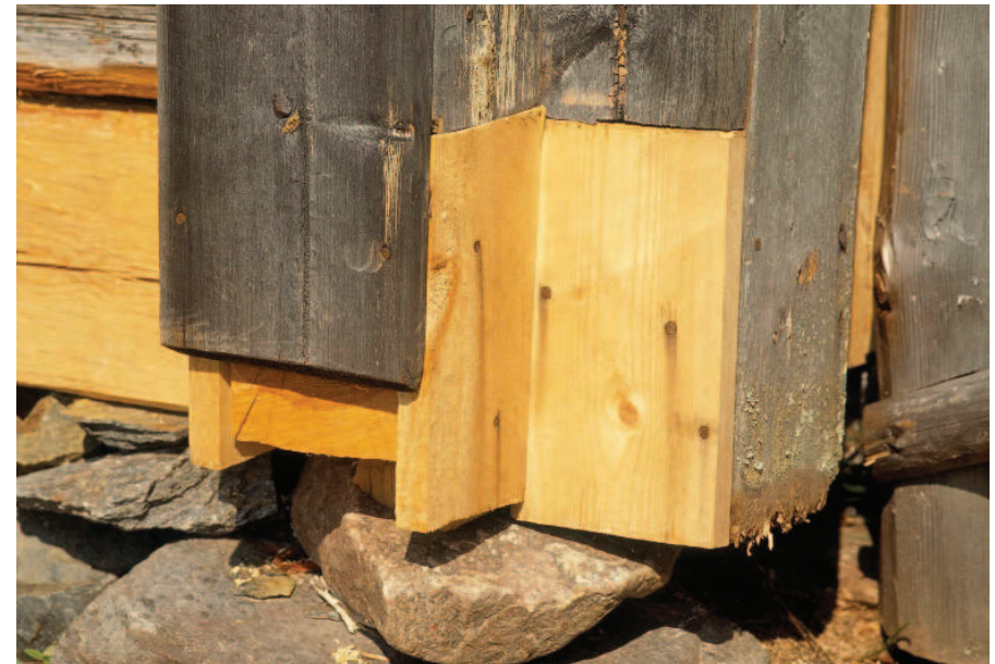
Kuva 232. Nurkan koteloinnin alaosa uusittuna. © Helena Hirviniemi, HH.
