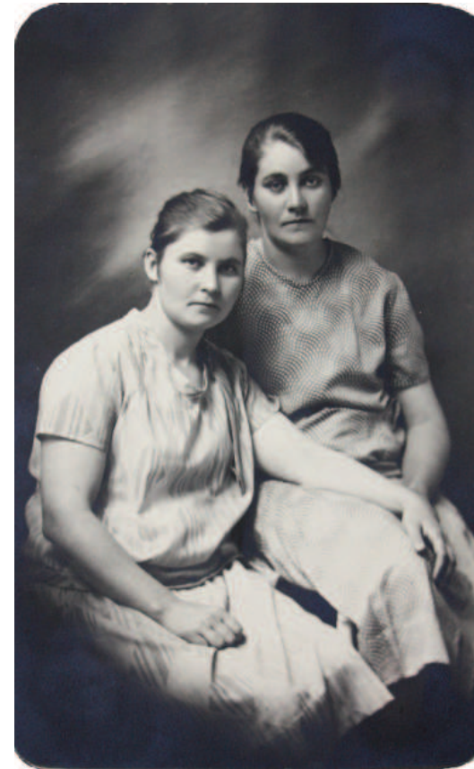
Kuva 166. Aini ja Iida Lamminaho.
