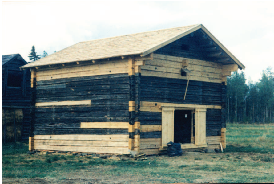
Kuva 256. Riihestä jouduttiin uusimaan paljon lahonneita osia.
