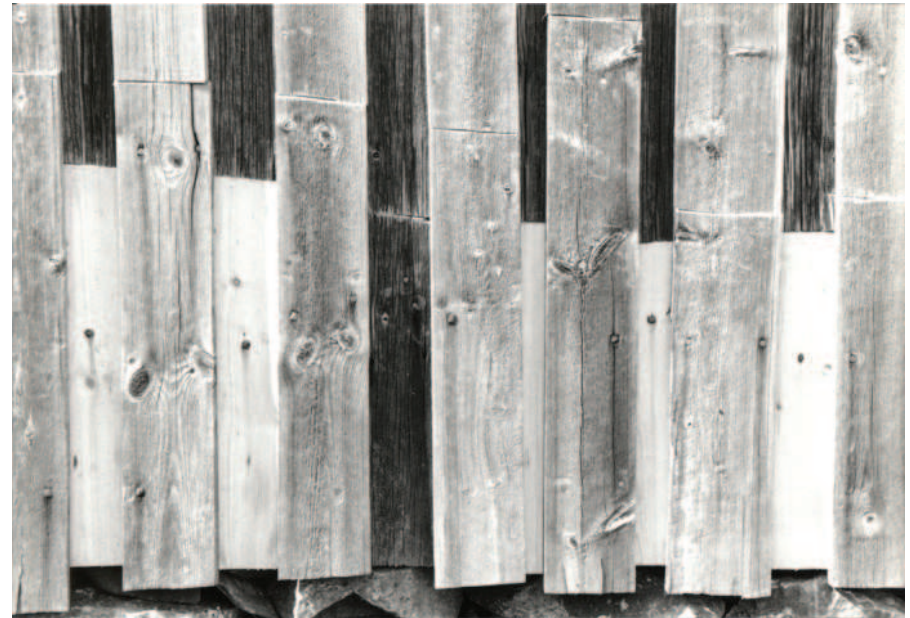
Kuva 237. Korjattu suojalautoituksen alaosa.
