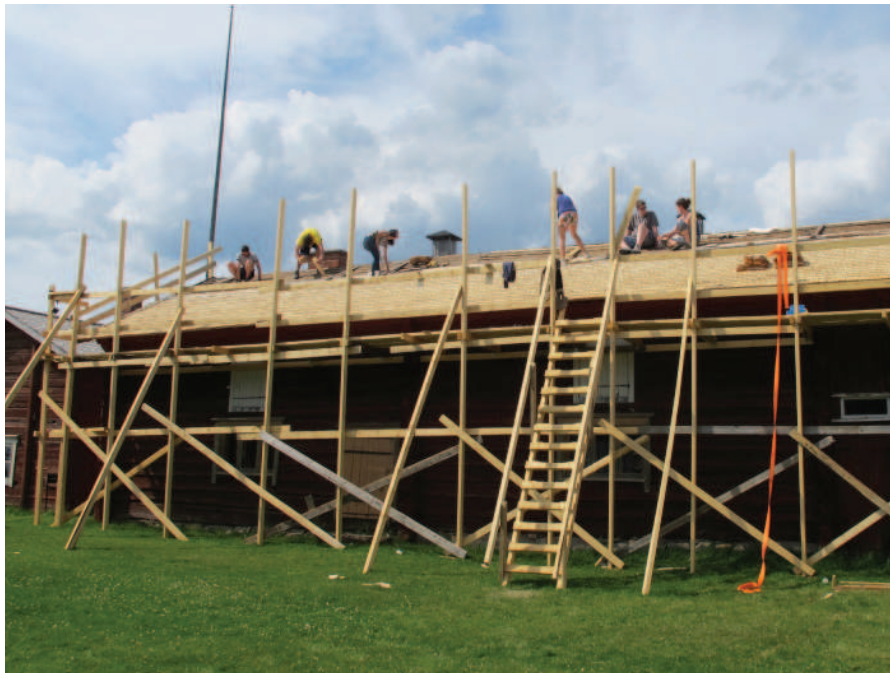
Kuva 252. Työleirillä vuonna 2011 uusittiin navetan pihan puolen lap- peen pärekatto.
