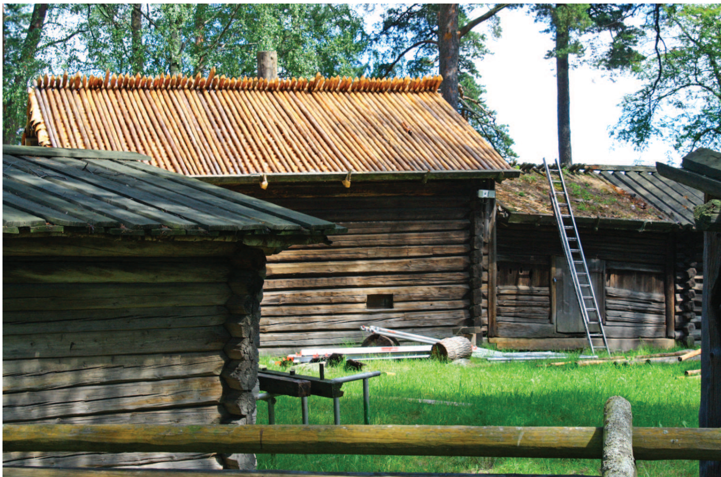
Kuva 265. Seurasaaren talomuseon rakennukset tarvitsevat jatkuvaa restaurointia ja huoltoa. Seurasaaren Niemelän torppan vasta uusittu tuohi-malkakatto. © Noora Puustinen
