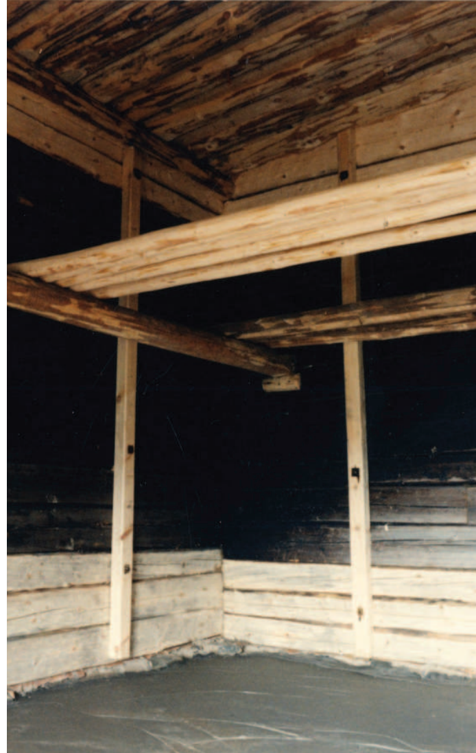
Kuva 199. Kengitetyssä riihessä uudet hirret erottuvat selvästi savun nokeamista vanhoista hirsistä. Hirsiiä on uusittu myös kehän yläosassa. Seinille on lisätty följarit, lattia on valettu uudelleen savi-maa-seoksesta ja riihen orret on uusittu.
