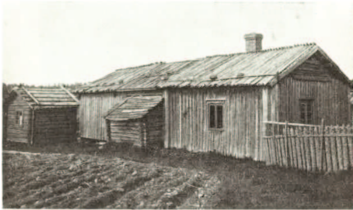
Kuva 99. Osin portuan sisälle rakennettu kellari. Laihon pientila Pyhämaalla.
