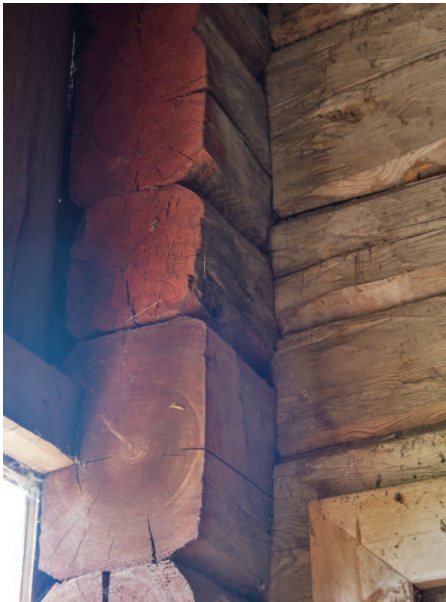
Kuvat 121. Lamminahon navetassa ylemmät, vanhemmat hirret erottuvat alemmista ja uudemmissa hirsistä. Navetta on kengitetty 1900-luvun alussa 9 hirsikerran kourkeudelle.
