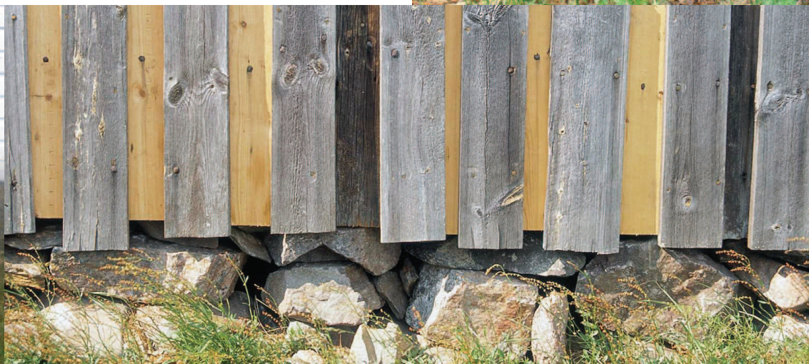
Kuva 24. Luonnonkivistä ladottu sokkeli. Kuvan rakennuksen suojalautoitus on vasta restauroitu.
