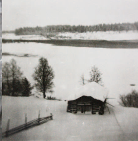
Kuva 173. Joen veden nousun alta purettu rantalato talvimaisemassa.
