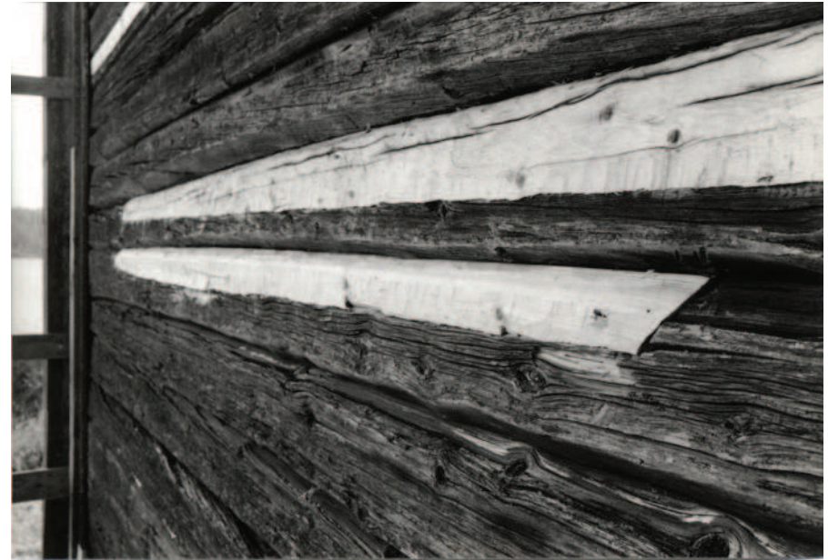
Kuva 203. Hirsipaikkoja viinaköökin seinässä. © Esko Männikkö 1999, HH.
