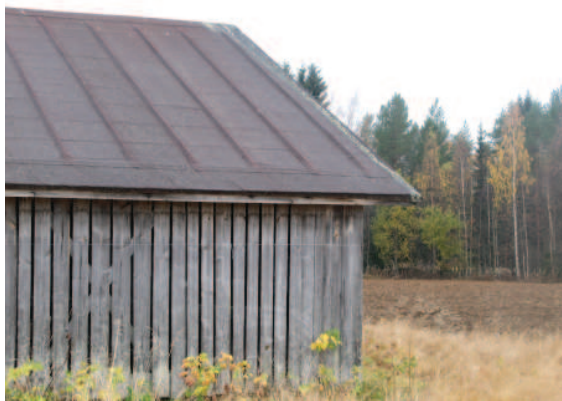
Kuva 35. Elosuojan katto on sälehuopainen.
