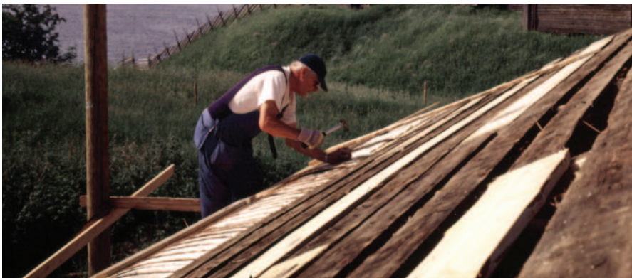
Kuvat 209. Vanhan tallin pärekattoa uusitaan.
