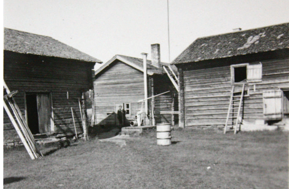
Kuva 138. Uusi viinakööki rakennettiin osaksi pihaa. Navetassa näkyvät pienet valoaukot on vaihdettu myöhemmin isompiin ikkunoihin ja kuvassa näkyvä ovi suljettu. Näkymä pihasta 1930-1940-luvulla.
