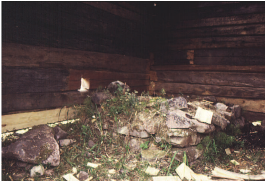
Kuva 231. Pajan kiuas ennen restaurointeja. © Helena Hirviniemi 1997, HH.
