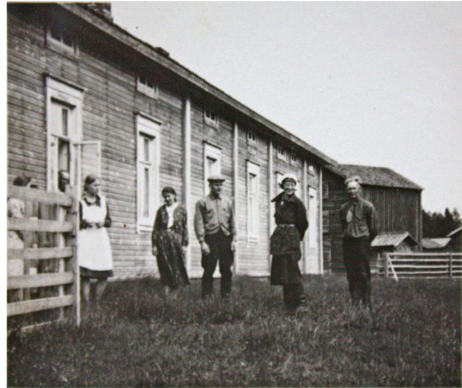
Kuva 144. 1930-luvun alussa otetussa valokuvassa oikealla näkyvä kellari on vielä eteistä lukuun ottamatta kattamaton.
