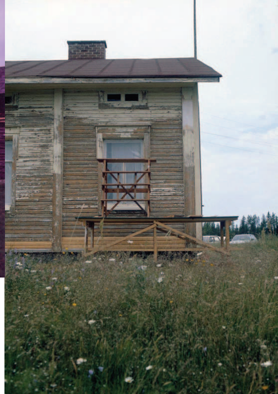
Kuva 218. Asuinrakennuksen maalin poisto meneillään. © Helena Hirviniemi, HH.
