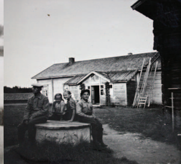
Kuva 174. Kaivon hirsikehikko vaihdettiin betonirenkai-siin 1950.
