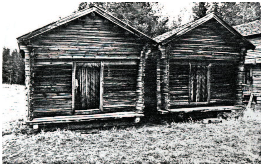
Kuvat 194 ja 195. Miesten ja naisten aitat ennen vuoden 1989 korjauksia. Aitat ovat painuneet osin maan sisään. Alemmassa kuvassa aitat on nostettu uudelleen nurkkakiville ja oikaistu.
