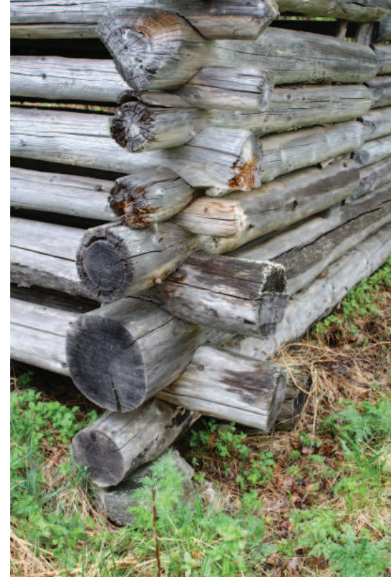
Kuva 23. Hirsikehät tehtiin luonnonkivisten nurkkakivien päälle. Vittasuon ladon nurkka.
