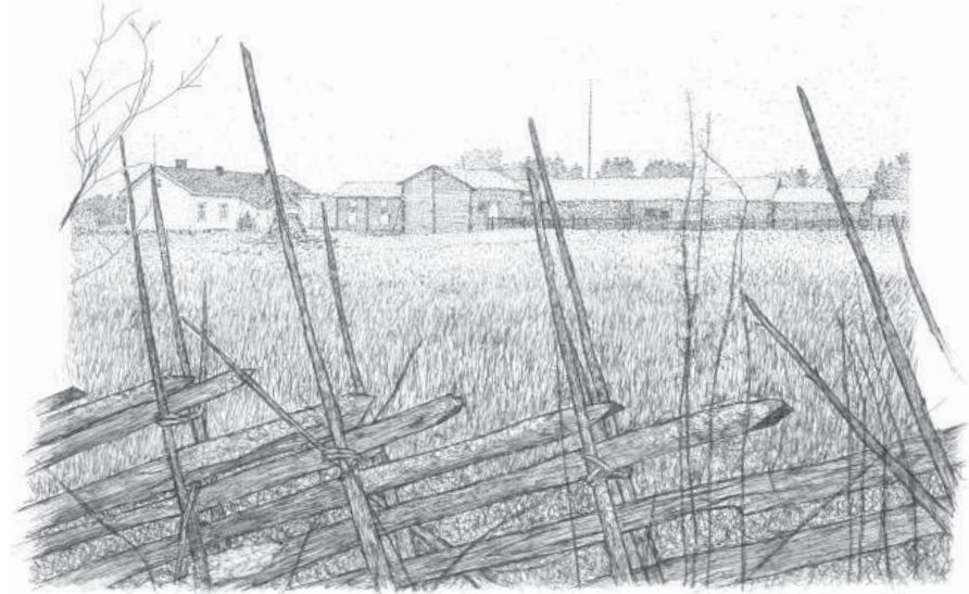
Kuva 49. Seipäät ylettivät usein reilusti aidan selkää ylemmäs, jotta niiden alaosan lahotessa niitä voitiin lyhentää alaosa seipäiden jäädessä vielä riittävän pitkiksi.
