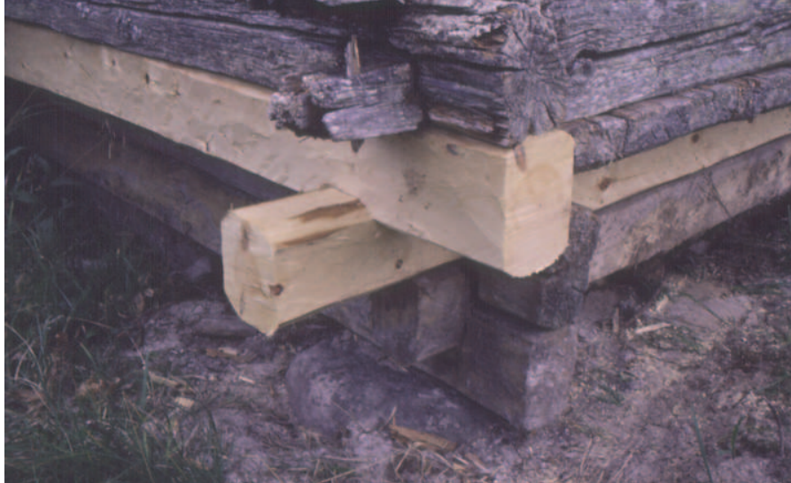
Kuva 198. Kengitetty aitan nurkka.
