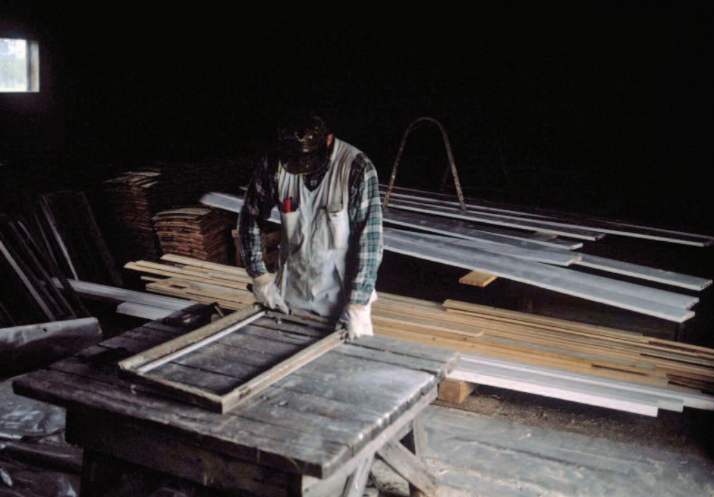
Kuva 219. Ikkunoiden maalin poistoa.
