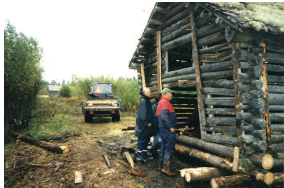
Kuva 206. Vittasuon latoja kengitettäessä käytettiin väliaikaisia följareita.
