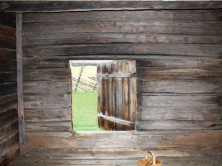
Kuva 293. Ruumenhuoneen oven kynnyks on kuitenkin hyvin korkea ja vaikuttaa merkittävästi kulkua tilaan.
