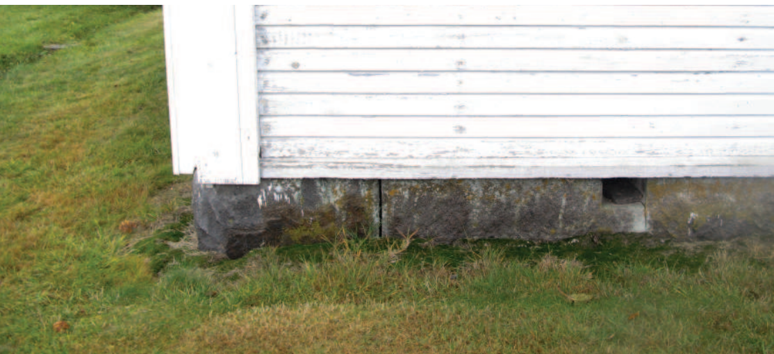
Kuva 22. Päärakennuksen nykyinen kivisokkeli on tehty hakatuista kivistä.
