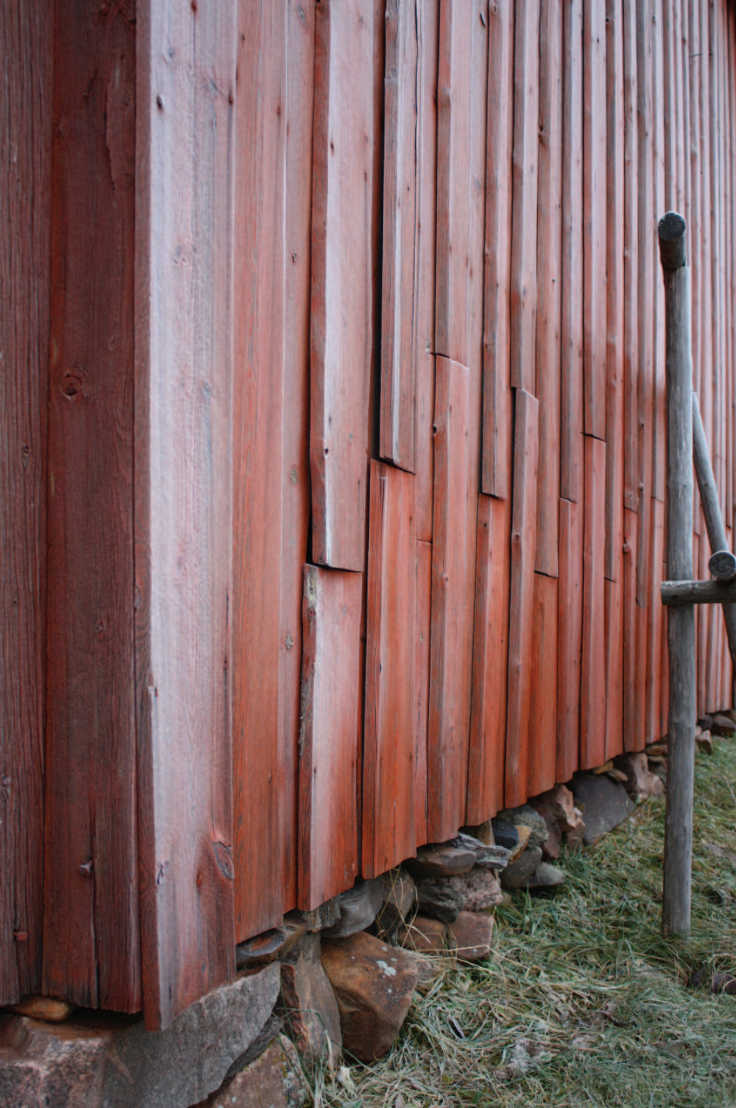
Kuva 214. Luhdin suojalautoituksen korjaus.
