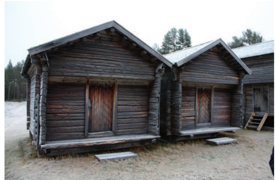
Kuva 96. Lamminahon miesten- ja naisten aitoissa on loveamattomat posket ja otsa.
