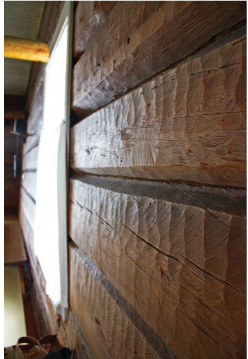
Kuva 47. Pirtin piiluttu hirsiseinä.
