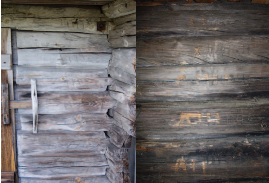
Kuvat 119 ja 120. Lamminahossa mm. sysikopissa ja ruumenhuoneessa on nähtävissä hirsiiin kaiverretut siirtomerkit.
