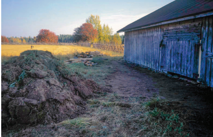
Kuva 196. Elosuojan ympäriltä on kuorittu maata.
