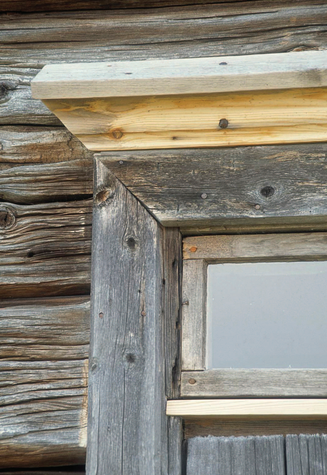
Kuva 237. Korjattu suojalautoituksen alaosa.
