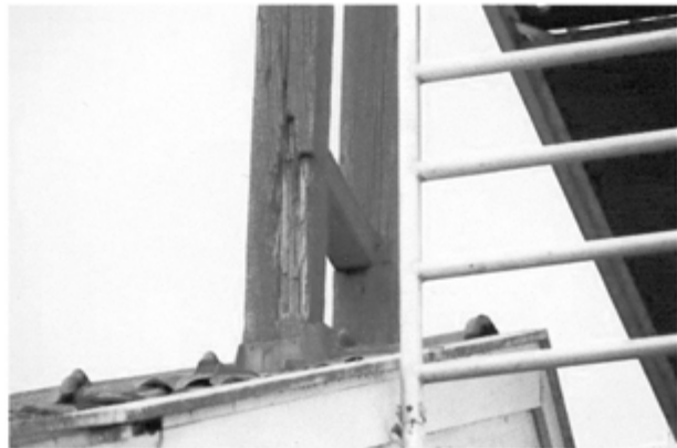
Kellotornin pystypuut olivat lahot
