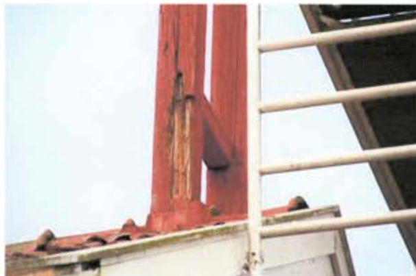
Kellotornin pystypuut olivat lahot
