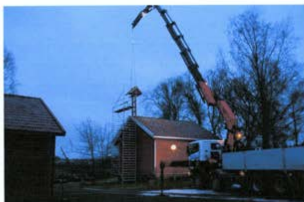
Nosturiauto nostaa korjatun kellotornin paikoilleen
