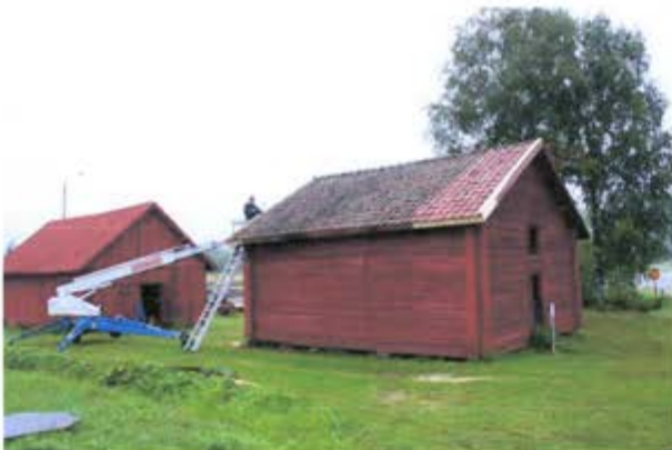
Aittarakennuksen katto puhdistuksen ja korjauksen alla
