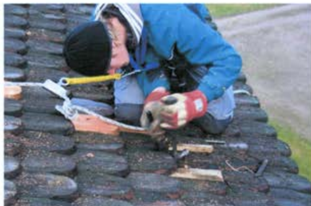
Restauroinnin opiskelija Mikko Niskanen vaihtaa paanua
