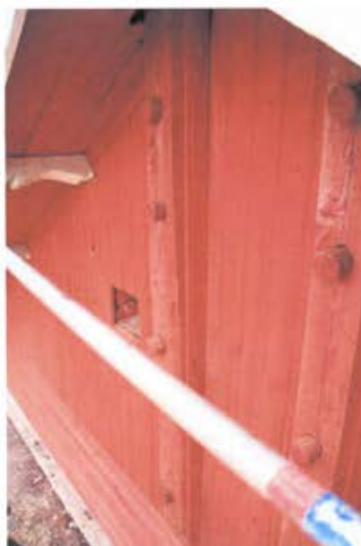
Pystyparrut on kiinnitetty seinään puutapeilla
