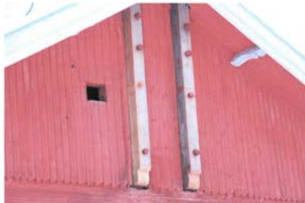
Tolppien reunoille kuuluvat vielä laudat, joiden puuttuminen huomattiin telineiden purkamisen jälkeen, ne asennetaan takaisin keväällä 2011
