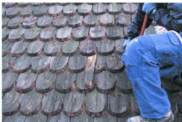
Kuvassa näkyy miten suuri osa ylälappeen paanuista oli halki, vaihdoinne paanut joiden puolikkaat olivat irti toisistaan
