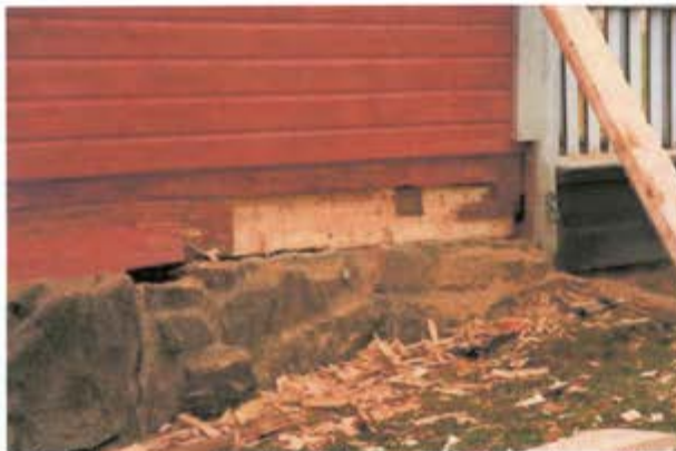
Laho hirsi veistetty pois, paikka kiinnitettiin tapittamalla
