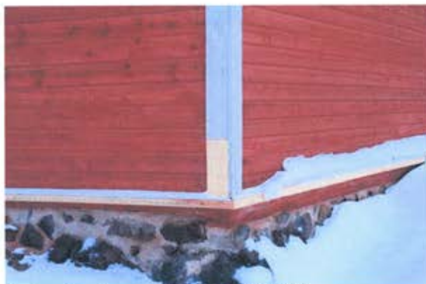
Uusitut tippalistat maalataan keväällä 2011
