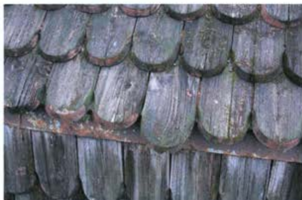
Osa paanuista oli tippumassa alas katolta
