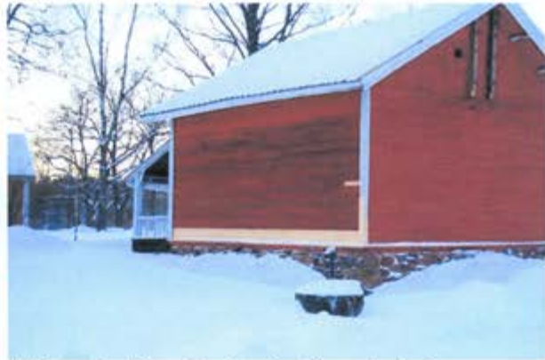
Uusitut tippalistat ja korjattuja ulkoverhouksia
