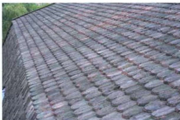
Paanukattoa ennen korjauksia
