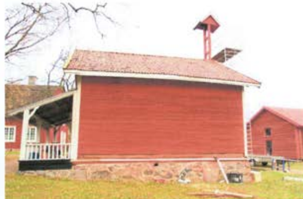
Ulkoverhousta jouduttiin purkamaan muutamia kerroksia tippalistan yläpuolelta
