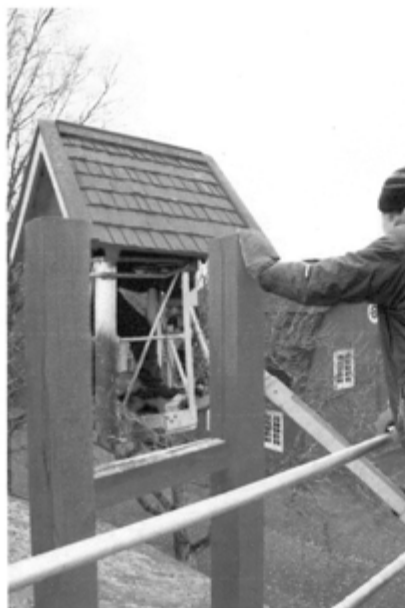
Katto otettiin ehjänä alas henkilönostimen avulla
