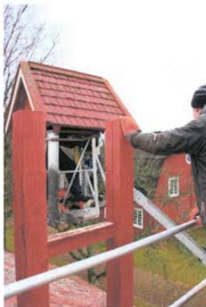
Katto otettiin ehjänä alas henkilönostimen avulla
