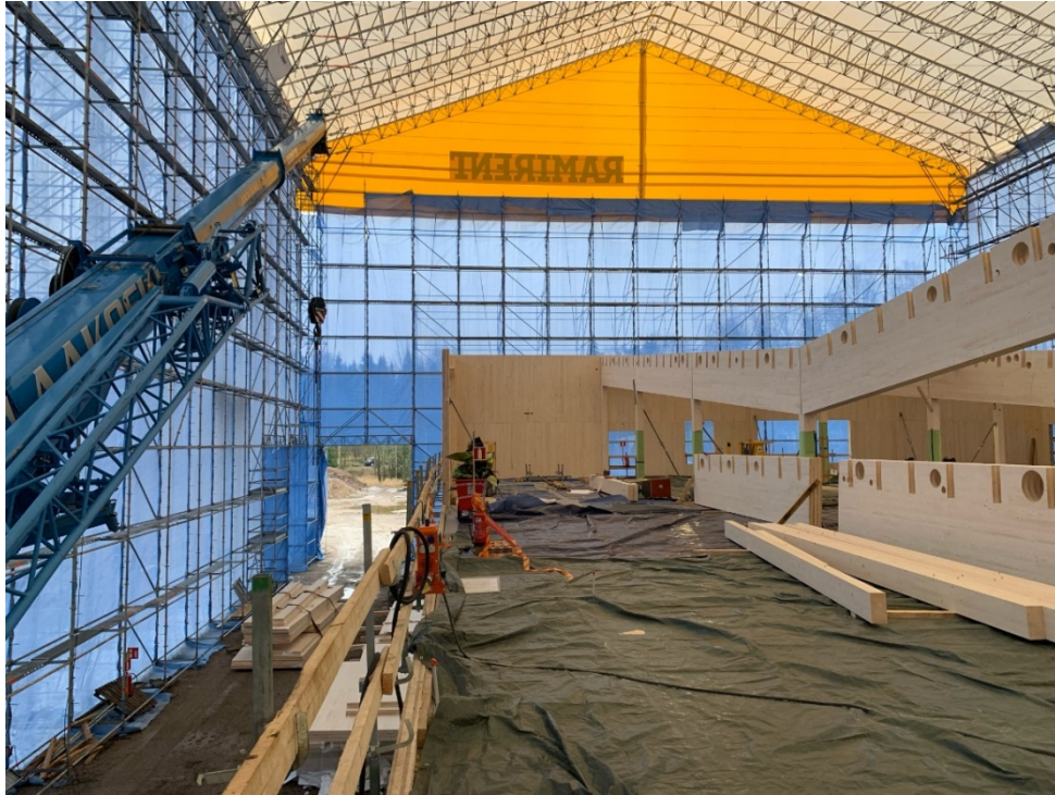
Koulun rakentamista sääsuojaissa maaliskuussa 2020.
