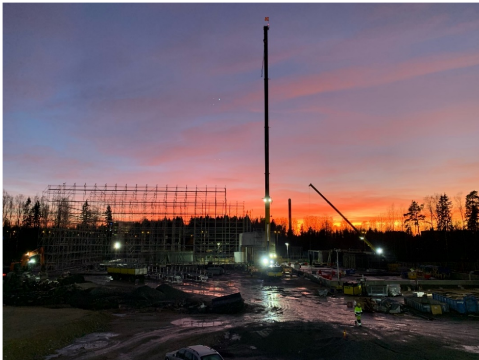
Työmaalla joulukuussa 2019. Kuva: Timo Juolevi
