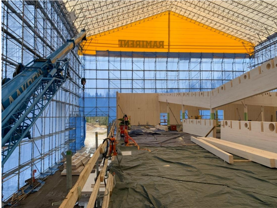
Koulun rakentamista sääsuojassa maaliskuussa 2020.
