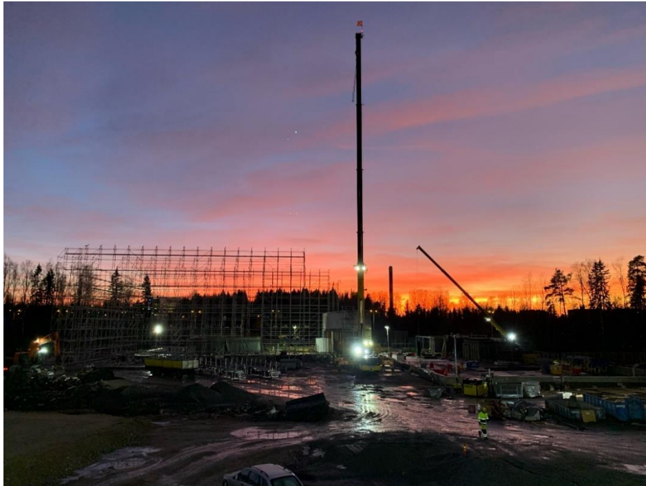
Työmaalla joulukuussa 2019. Kuva: Timo Juolevi
