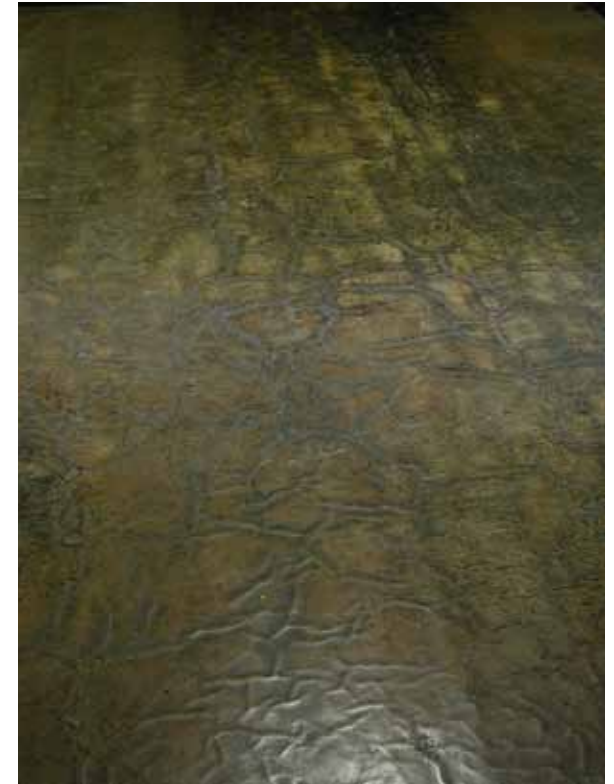
Pintoja peruskorjauksen ajalta: oikealla 2. kerroksen pohjoispään moneen kertaan maalattua asfalttimassalattiaa.
