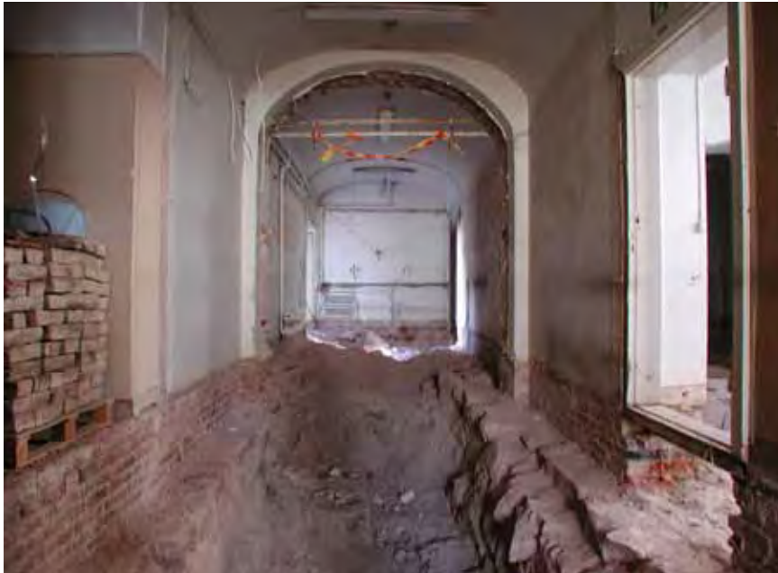
Peruskorjauksen yhteydessä rakennuksen eteläpään alapohja avattiin käytännössä kokonaan, pohjoispäässäkin varsin laajalti. Alkuperäisen hormiston laajuus näkyy seinän alaosassa.
