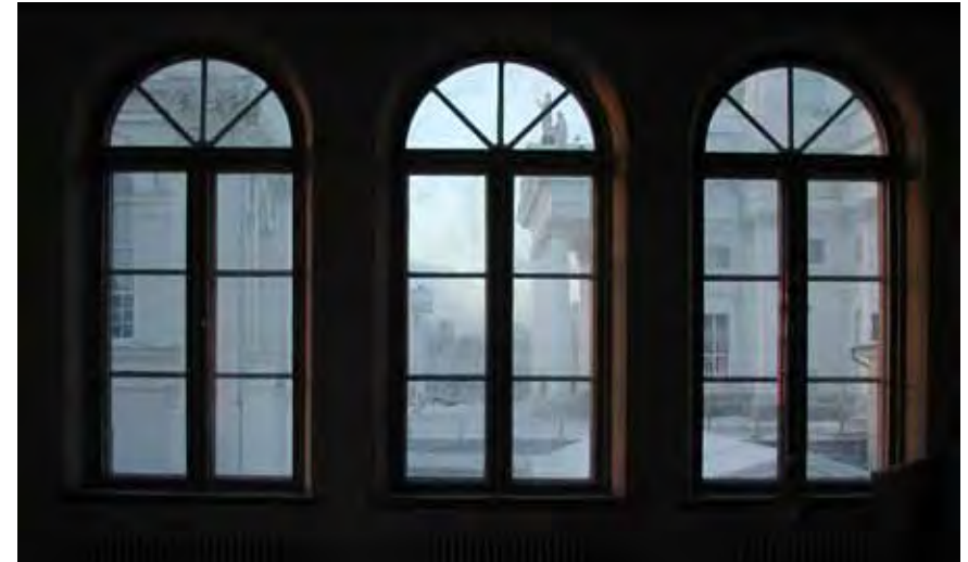
Peruskorjauksen aikaisia kuvia ikkunoista ja ovista. Yllä kolmannen kerroksen päätysali, josta kauniit näymät Tuomiokirkon suuntaan.
