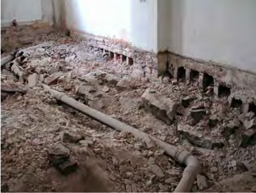
Peruskorjauksen yhteydessä rakennuksen eteläpään alapohja avattiin käytännössä kokonaan, pohjoispäässäkin varsin laajalti. Alkuperäisen hormiston laajuus näkyy seinän alaosassa.
