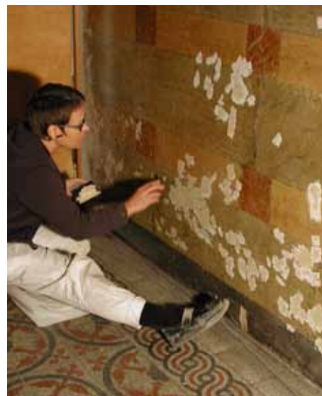
Kuvia vuosilta 2001-2003. Alla konservattori Arja Sorri tekee maalipuutteiden paikkausta. Oikealla kuva 2. kerroksen palopostin sisään jääneestä alkuperäisestä maalipinnasta.
