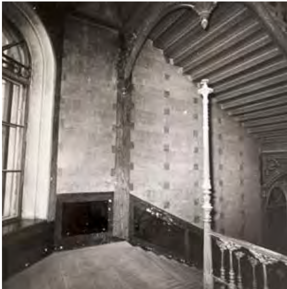
Kuva 1977 toimitetusta kuntokatselmuksesta, jossa käytiin läpi julkisivut sekä neljännen kerroksen alakattojen vauriot. Lisäksi on muutama kuva pääporashuoneesta; vasemmalla toinen lepotaso. HYM
