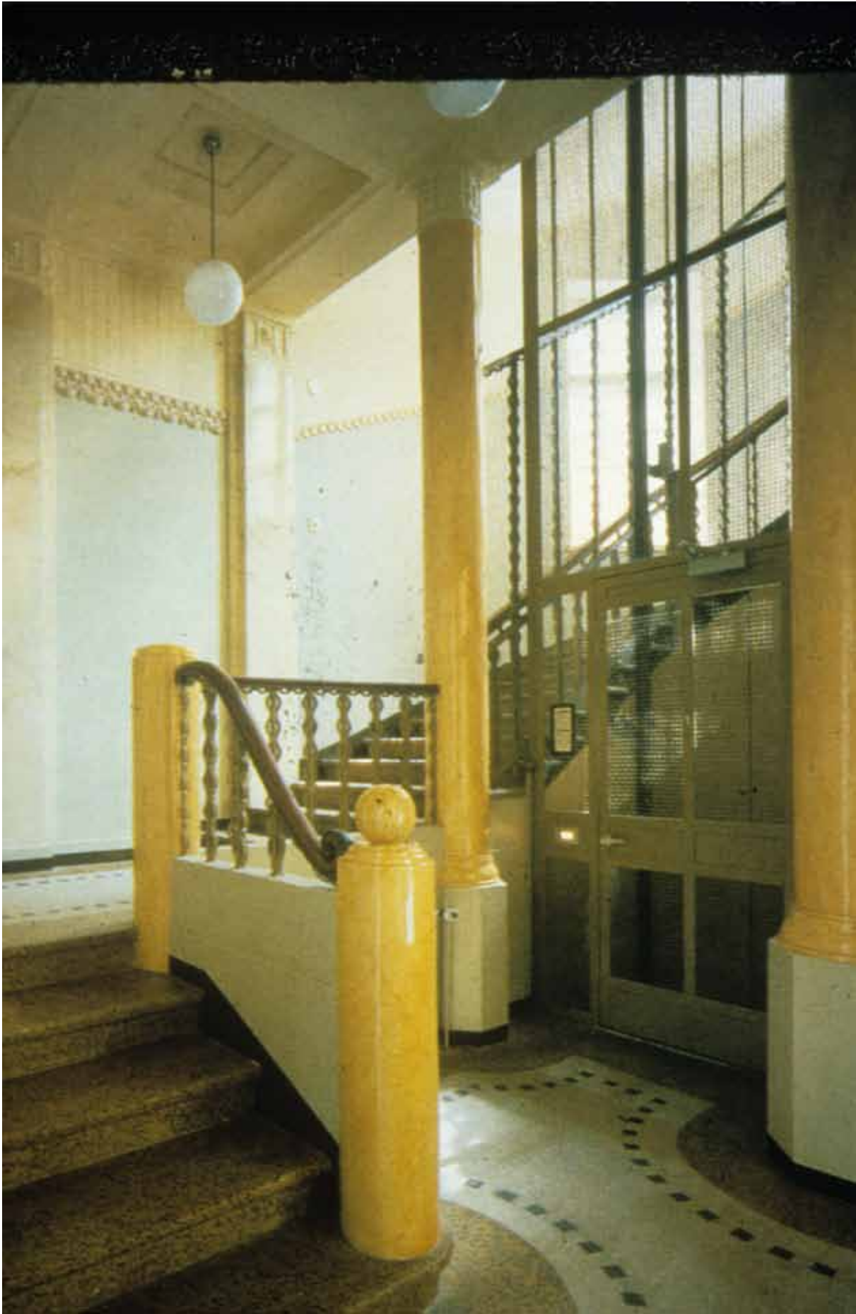
Porrashuone 1984 entisöitynä. Kuva Arvi Ilonen.
