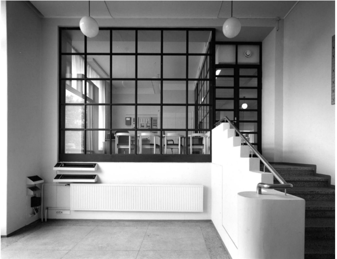
Eteisaula korjauksen jälkeen 1984. Simo Rista. PA Ilonen yksit. arkisto.
