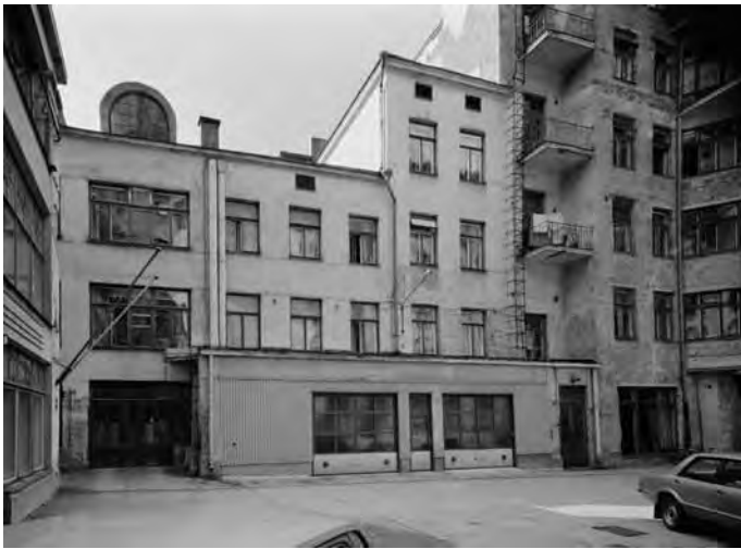
Sisäpihan autotalli. Johnny Korkman, 1981. MKA.
