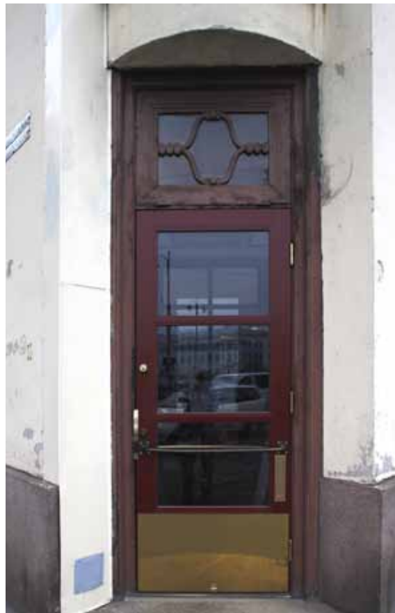
Ovi katujen nurkassa. 2010. SH.
