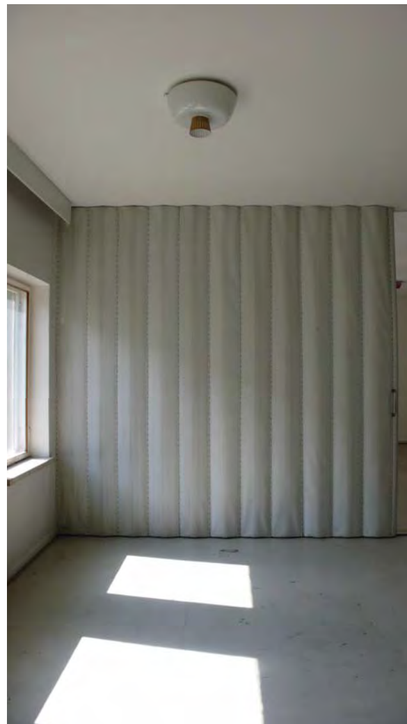
Oppilasruokalan 203a katto on rapattu ja maalattu.
