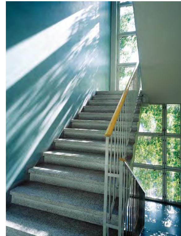
Luokkasiiven päädyn portas 08 vuonna 2002: mosaiikkibetonia, lakattu koivuinen käsijohde, Lindroosien värisuunnitelman mukaisesti vihreäksi maalattu sivuseinä (kuva: Heikki Rautio).
