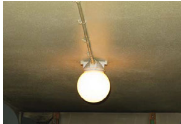
Vedenpitävä posliinikantainen kattovalaisin, Orno 14-351/451/551 (kellarin varasto K13).
