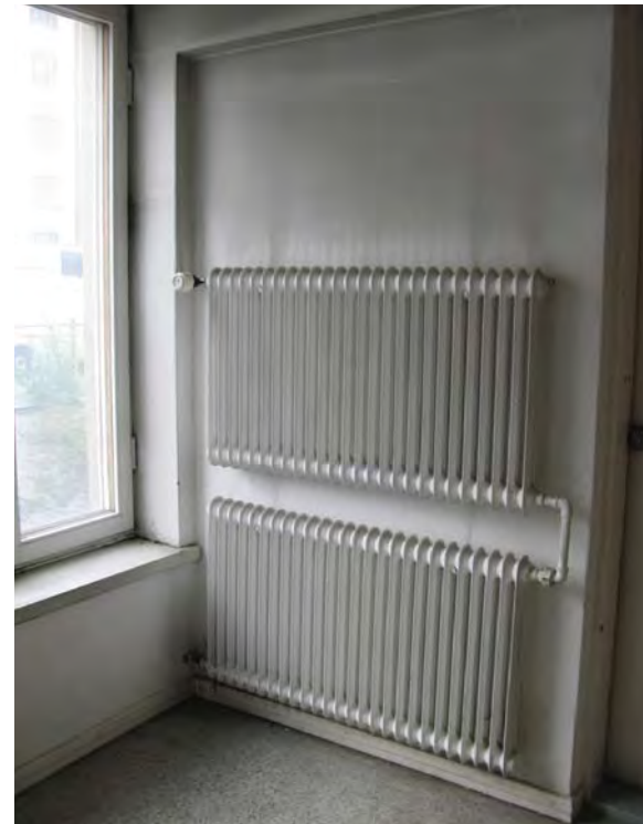
Högforsin Kesto-radiaattori (luokkasiiven kellarin käytävä).
