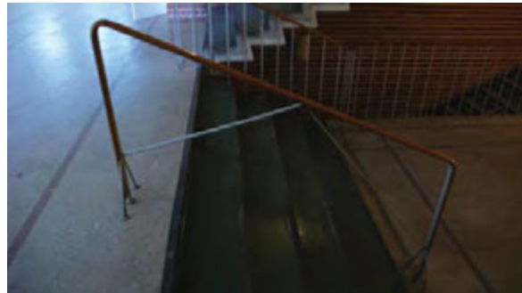
1. kerroksen aulan portaan kaiteeseen on lisätty diagonaalituet.
