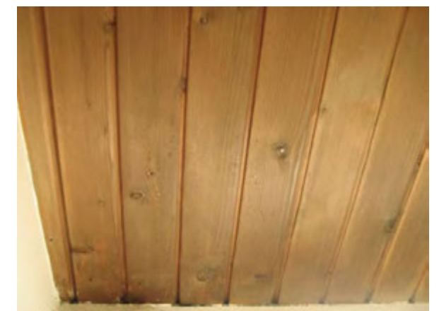
Pontattu mäntypaneelialakatto (kellarin saunaosaston wc)..
