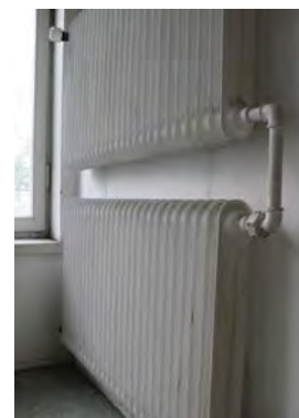
Högforsin Kesto-radiaattori (luokkasiiven kellarin käytävä)
