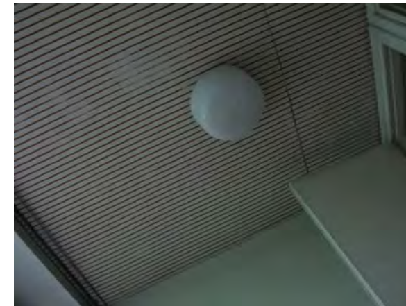
Levykatto uritettua akustoinsuliittia (opetusvälinevarasto 147, 1. krs).
