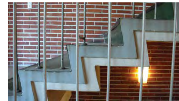
Pääportaan askelmat (ylh.) ja kaide (oik.) 2. kerroksessa kuvattuina.
