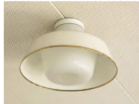
Kattovalaisin 71-147 opaailiasia ja maalattua metallia messinkireunuksella, Orno / Johansson-Pape (luokkahuone 142, 1. krs).
