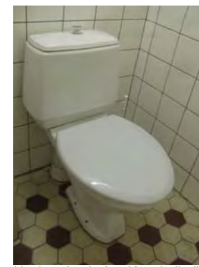
Uusi wc-istuin (wc K37, kellari).
