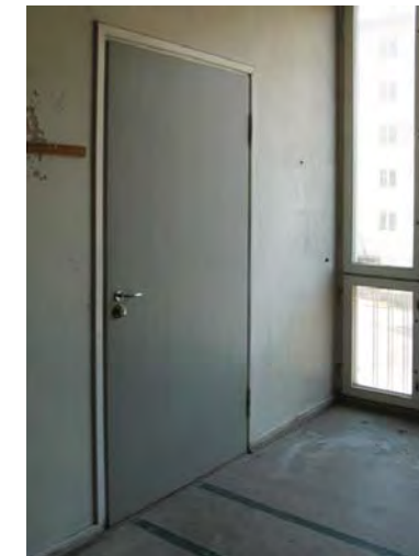
Ovi tyyppi 2, (2. kerroksen käytävä 201.)
