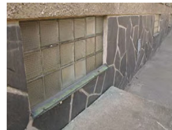
Koillisjulkisivun lasitiili-ikkunoita.
