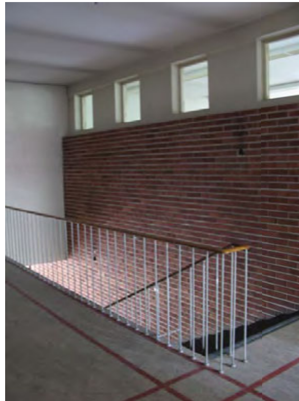
3. kerroksen porrassala 301 ja auditorion 302 tiiliverhoilu, ikkunallinen sivuseinä.
