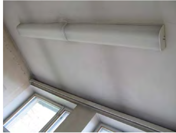
Ornon poikkileikkaukseltaan aaltomainen loisteputkivalaisin uritettua akryyliä, ollut ehkä alun perin kirjastossa (kirjastonhoitajan huone 305, 3. krs).
