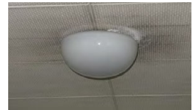
Pisaramainen kattovalaisin, Orno 70-013? (käytävä 211, 2. krs.).
