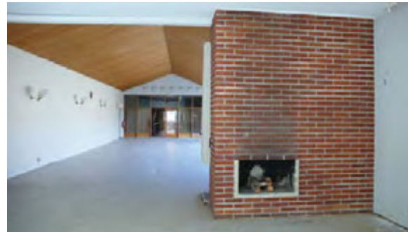
Oppilasruokalan 202 ja 203a välinen punatiilistä muurattu takkaseinä.
