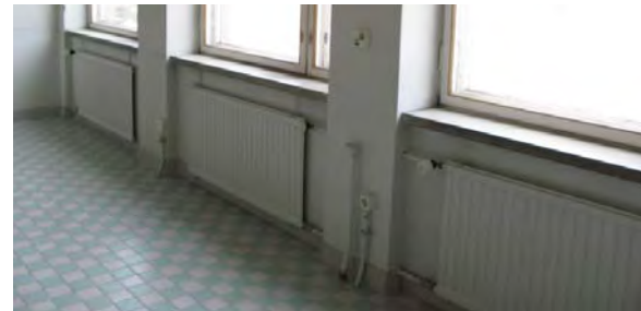
Högforsin paneeliradiaattorit.
