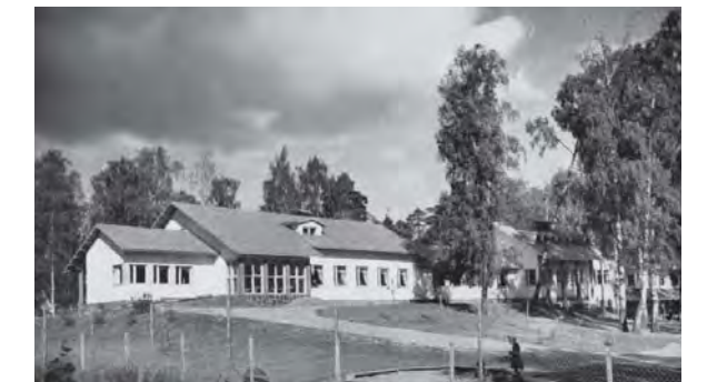
Lindroosien suunnittelemassa Arabian tehtaiden lastentalossa (1943–44) on etenkin 1950-luvun alun arkkitehtuurille tyypillinen laakea tiilillä katettu harjakatto, roiskerappaus ja liuskekivisokkelit, samoin kuin muun muassa Kotitalousopettajaopistossa, Härmälän ja Launeen seurakuntataloissa sekä Lindroosien omassa talossa Helsingin Munkkiniemessä. Kuva kirjasta Suomen teollisuuden arkkitehtuuria (1952) /Foto Roos.
