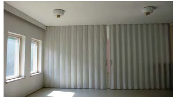
Oppilasruokalan 203a ja opettajien ruokalan 203b välissä on kangaspäällysteiset paljeovet.
