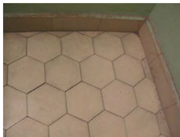
Wc-tilojen ja siivouskomeroiden lattialista on Pukkilan puolikkaista laattoja.
