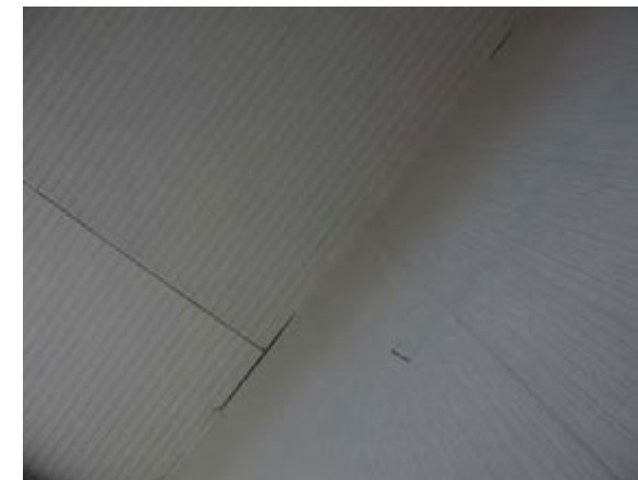
Levykatto uritettua akustoinsuliittia (toimistuhuone 134, 1. krs).
