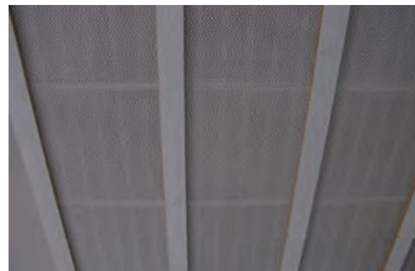
Ruokailutilassa 113 on Soundex-alakattolevyjen saumakohtien päälle myöhemmin kiinnitetty kapeat, valkeiksi maalatut rimat.
