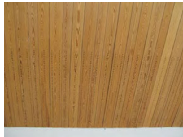
Oppilasruokalan 202 mäntypaneelikatto ilmastointireikineen.
