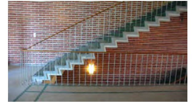
Pääporras 2. kerroksen kohdalta kuvattuna.
