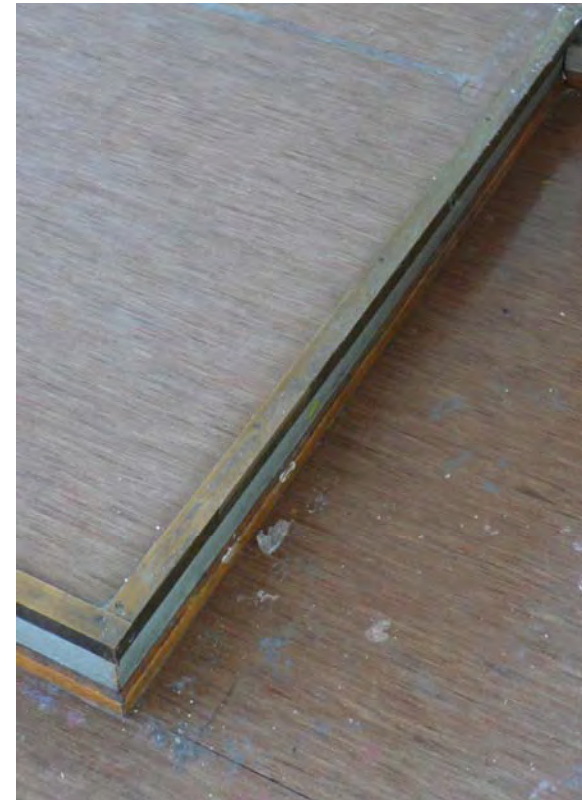
Alkuperäisellä Jaspe-matolla päällystetty opettajankoroke messinkisine kulmalistoineen ja tammisine mattolistoineen (luokka 310, 3. krs.).
