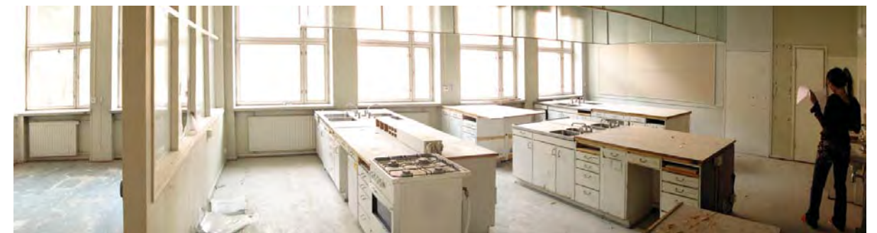
Ruokailutila 113 ja opetuskeittiö 114 (kansakoulukeittiö). Opetuskeittiön höyrykuvut, lankavetimillä varustetut kiintokalusteet ja opettajanpöytä ovat alkuperäiset.
