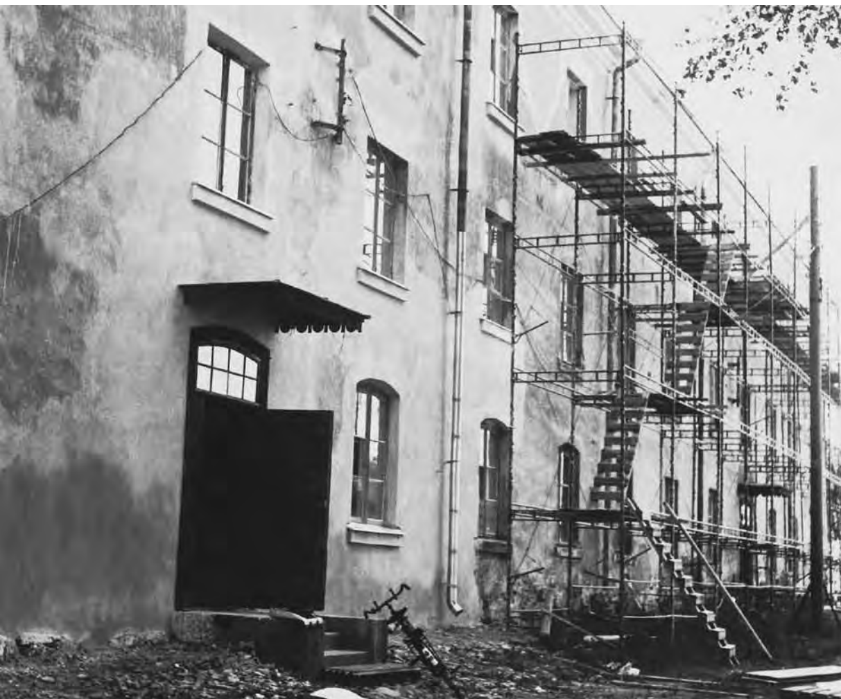
Rakennus D 14 läntinen julkisivukatoksineen. Ei vsl. MV RH
