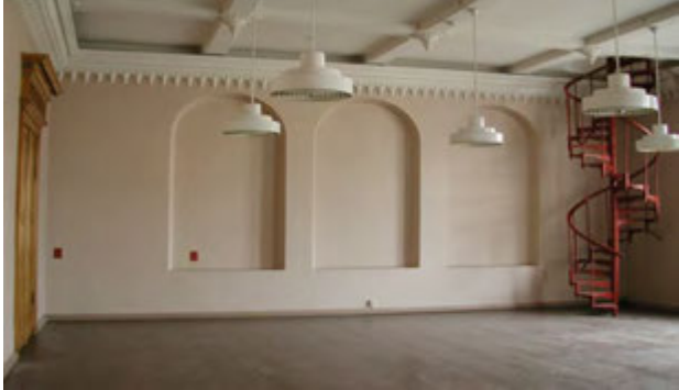
Koroke väliseinän kanssa samanaikainen, kuva kesällä 2001.
