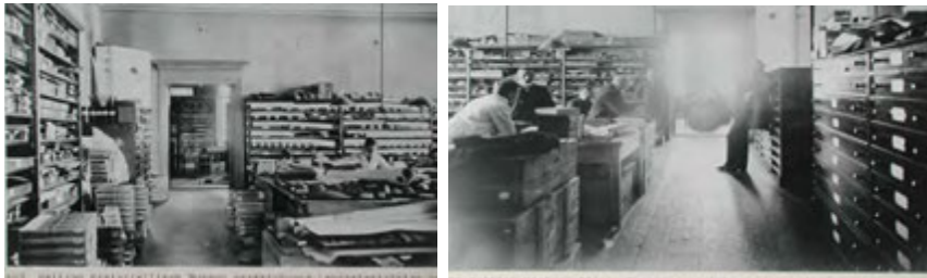
Alla olevat valokuvat noin vuodelta 1910, Valtion Historiallisen Museon varastuhuoneesta. Kuvat lainattu Veikko Pakkasen gradusta, originaalit MV. Alimmassa kuvassa näkyy, että ovi käytävään on ollut suljettu, vahvistaa siis oletusta pimiöstä tms.
